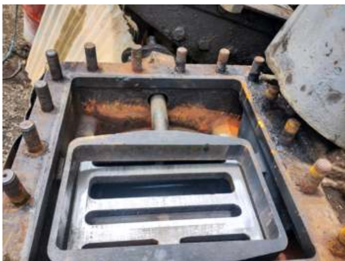
◆ Detalhe da manutenção da loc. 9, assentamento do conjunto. Foto HGF
