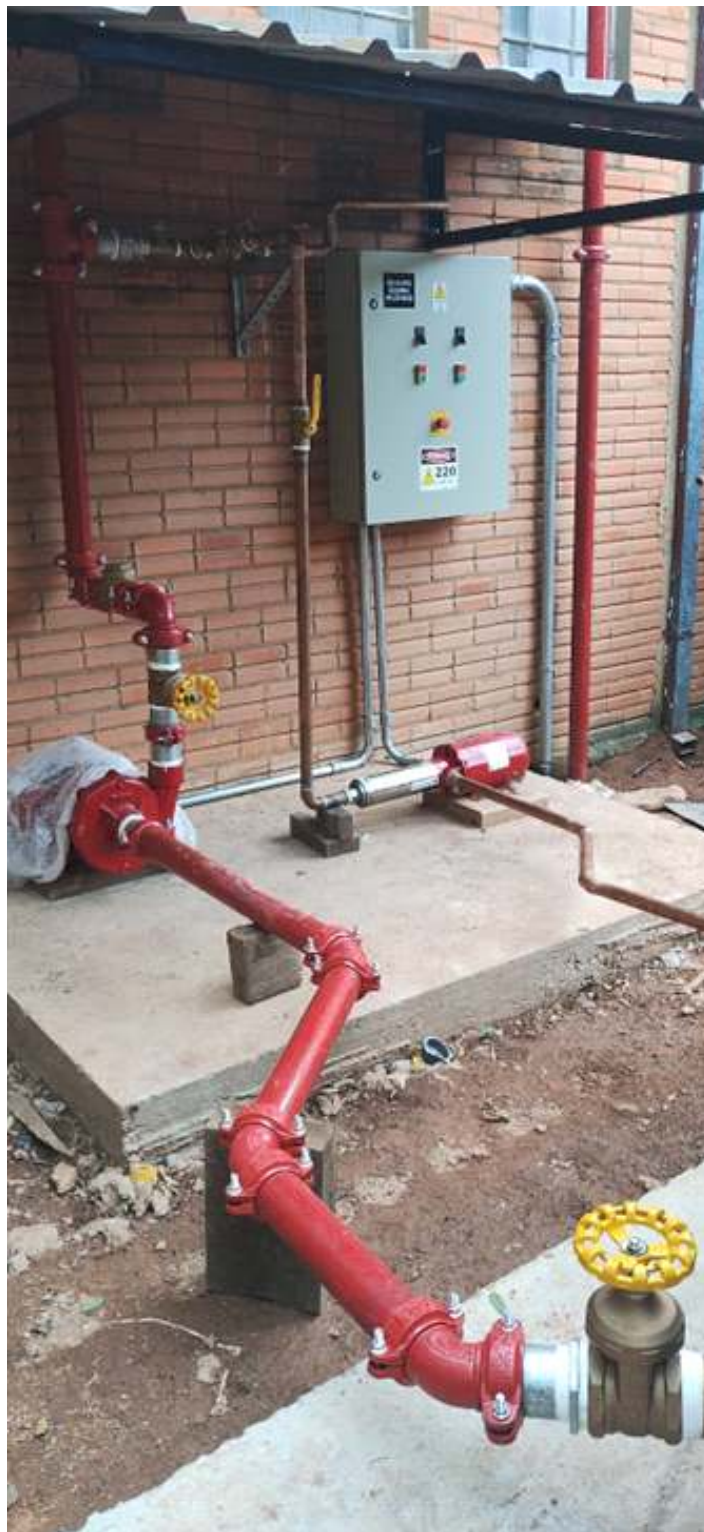
◆ Instalação do sistema de hidrantes em Carlos Gomes. Foto HGF.
