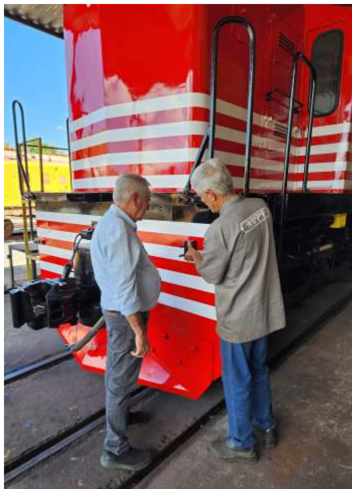
◆ Instalação dos acabamentos e acessórios.
