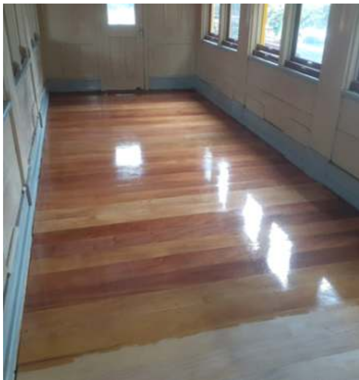
♦ Novo piso recebendo o tratamento de proteção e acabamento. Foto Fabiano Silva.
