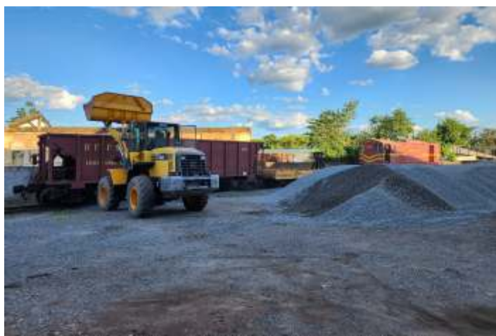
♦ O vagão hopper já completamente carregado, pronto para sair para o trecho para aplicação do lastro.
