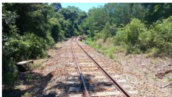
◆ Serviço de substituição de dormentes na via.
