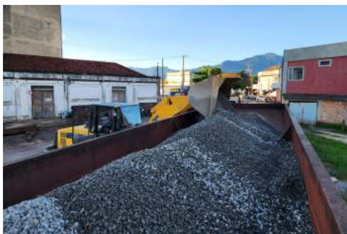
♦ Operação de carregamento do lastro no pátio de Cruzeiro.
