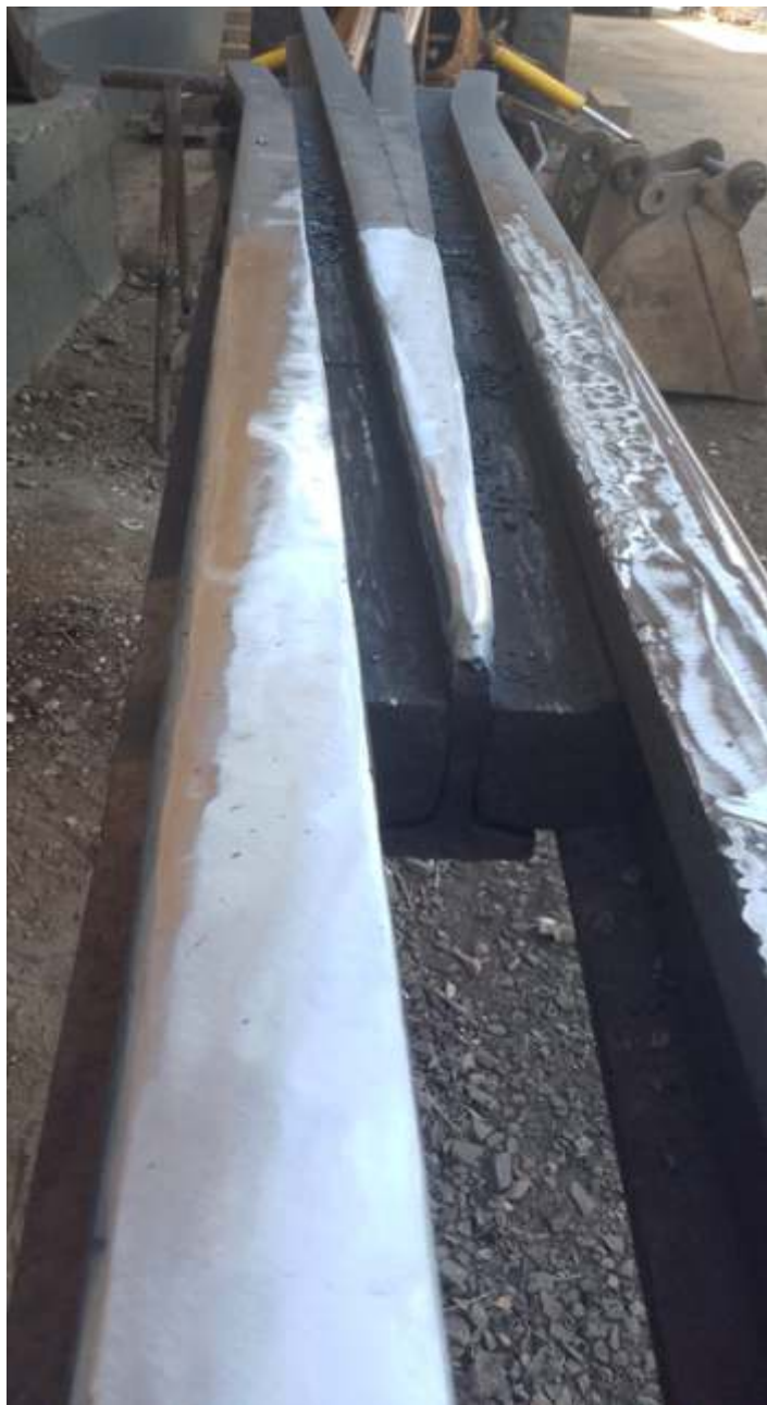
◆ Reforma de um jacaré para ser instalado no pátio de Tanquinho. Foto Márcio Silva.
