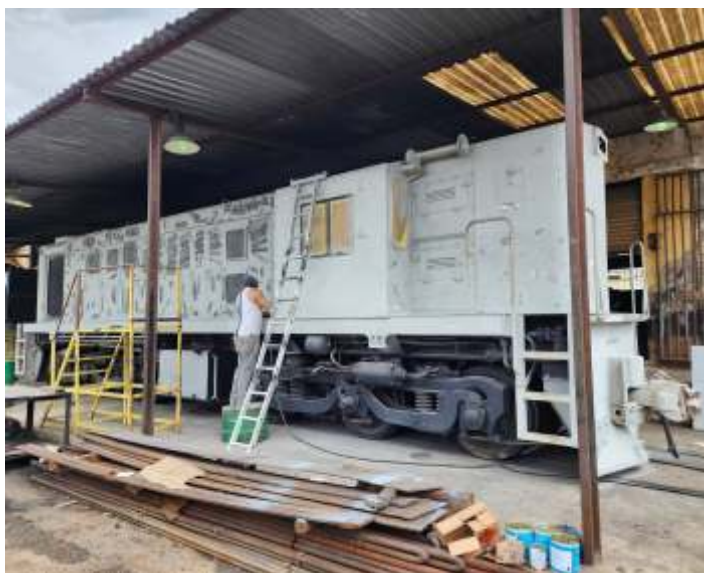
◆ Preparação final para receber a pintura.
