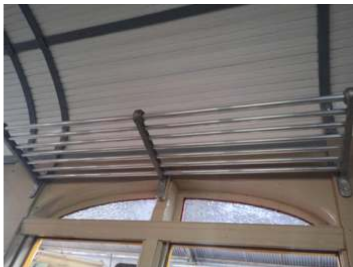
◆ Detalhe do maleiro reconstruído em alumínio. Foto HGF.
