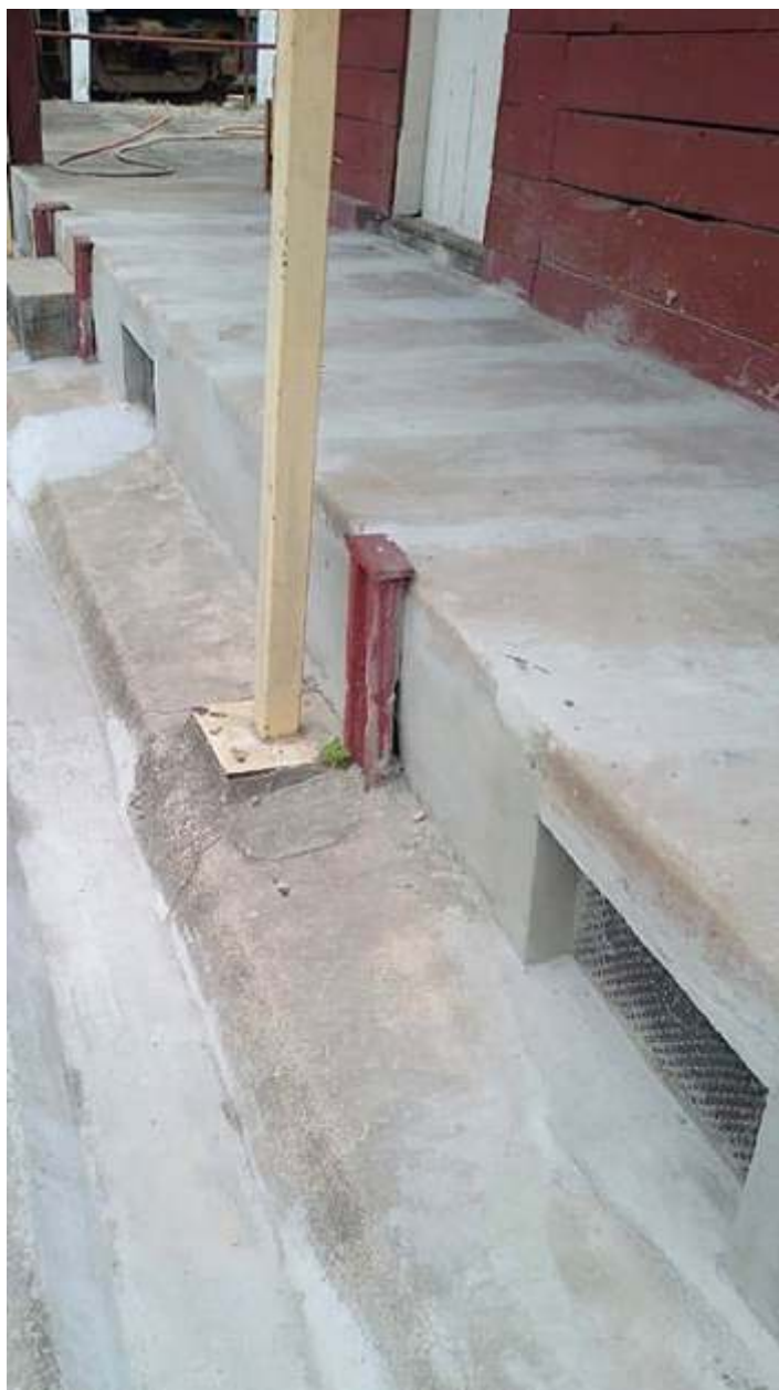
◆ Parte da estrutura do Museu que foi reformada e a recolocação das antigas grades SPR no entorno.
