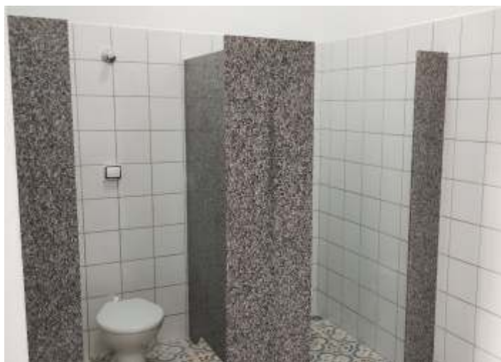
◆ Aspecto do novo sanitário feminino. Faltam apenas detalhes como as portas que já estão sendo confeccionadas, instalação de papeleiras e saboneteiras.
