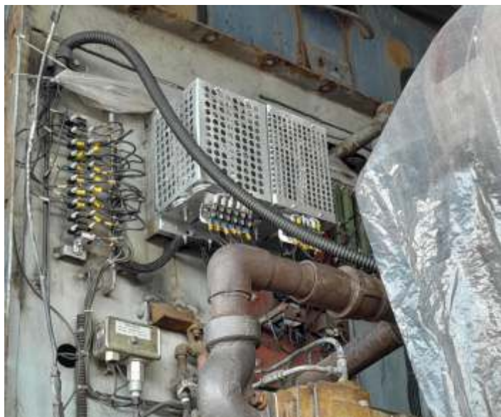
♦ A parte elétrica da 3111 está sendo refeita.
