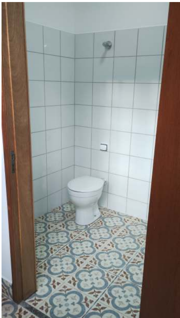
◆ Aspecto do sanitário para atender portadores de necessidades especiais. Faltam apenas detalhes como a instalação das barras de apoio, das papeleiras e saboneteira.
