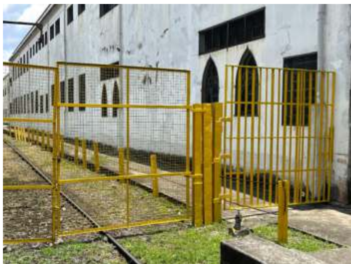
◆ Portões de acesso a Regional (pedestre e ferroviário) ganharam nova pintura para um maior destaque das estruturas, anteriormente na cor vermelho goya, estavam bem degradados até então.
