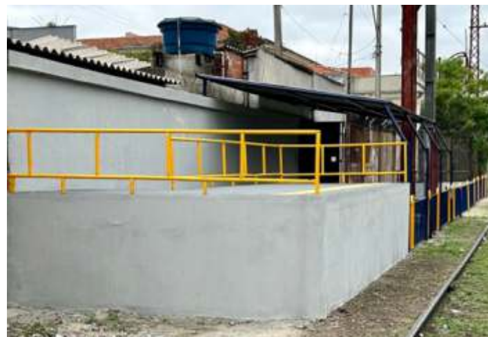
◆ Vista da nova plataforma de embarque após a conclusão dos trabalhos.
