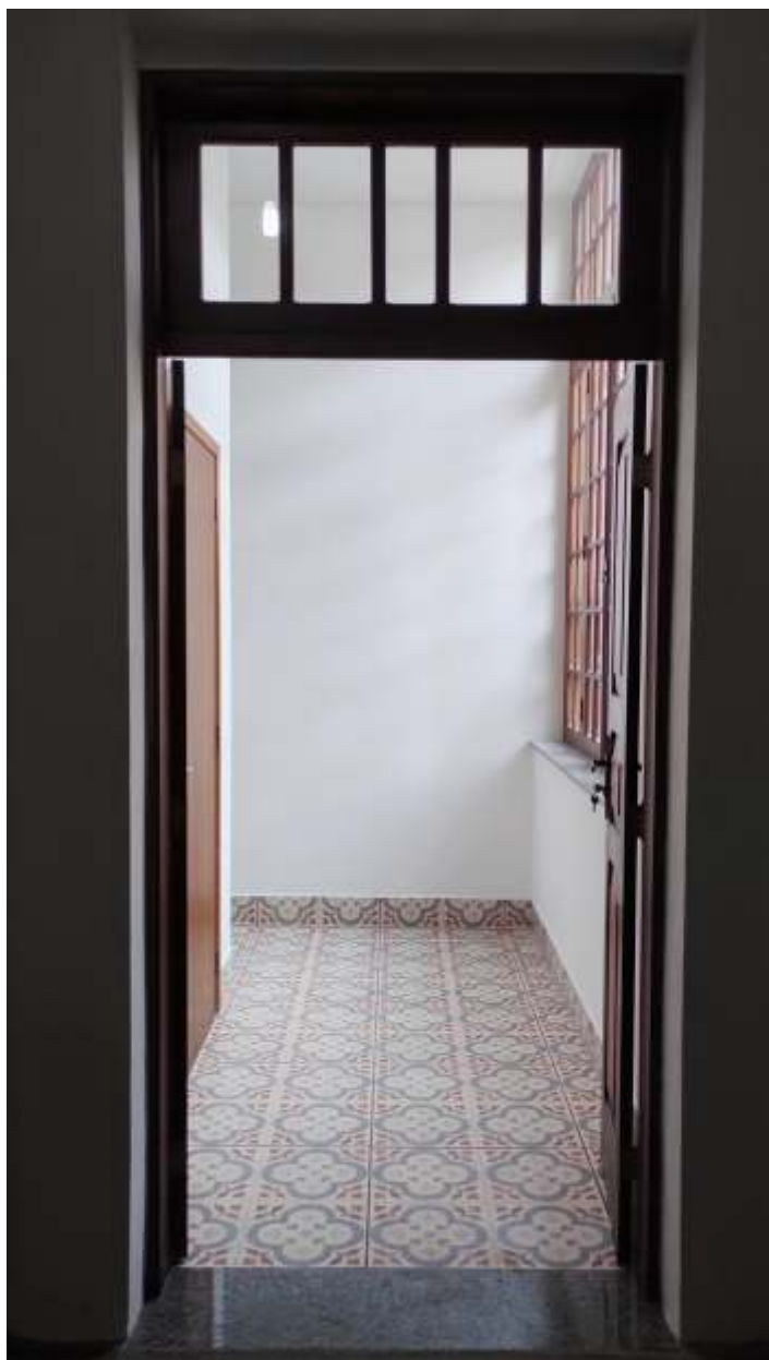
◆ Aspecto do acesso aos novos sanitários; logo a esquerda, o sanitário acessível e mais ao fundo o acesso para o novo sanitário feminino bem como o exclusivo das colaboradoras.
