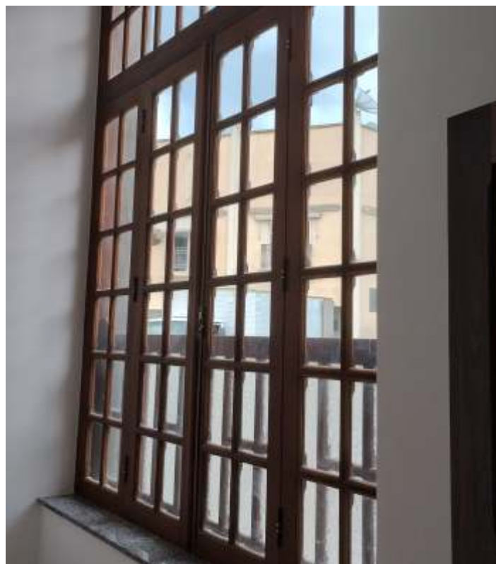
◆ Nova janela, confeccionada nas oficinas de São Lourenço.
