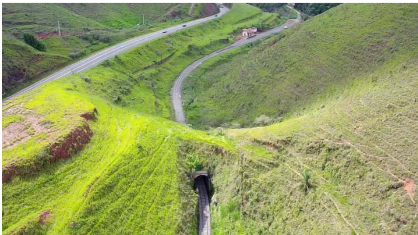
♦ Aspectos da via próximo à estação Rufino de Almeida após a conclusão dos trabalhos de recuperação. Fotos: Renner Rotta
