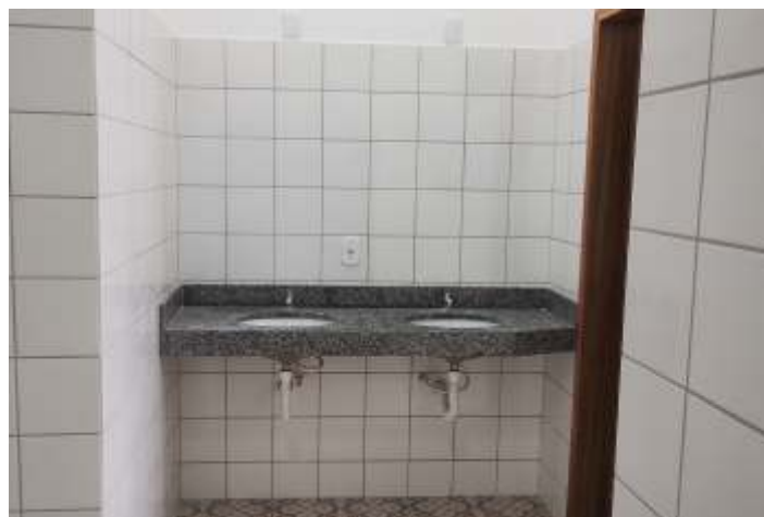
◆ Aspecto dos lavatórios do novo sanitário feminino. Faltam apenas detalhes como a instalação do espelho e das papeleiras e saboneteiras.
