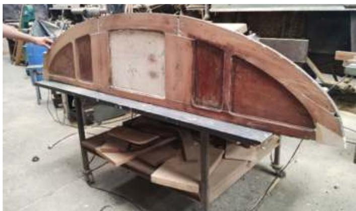
♦ Detalhe de uma peça da testeira interna, onde após reparo e lixamento, foi encontrado os resquícius do período em que eram envernizados. Devia ser uma maravilha. Foto HGF.
