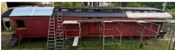
♦ Início da aplicação da manta asfáltica de 3,0mm no teto do carro #1032.
