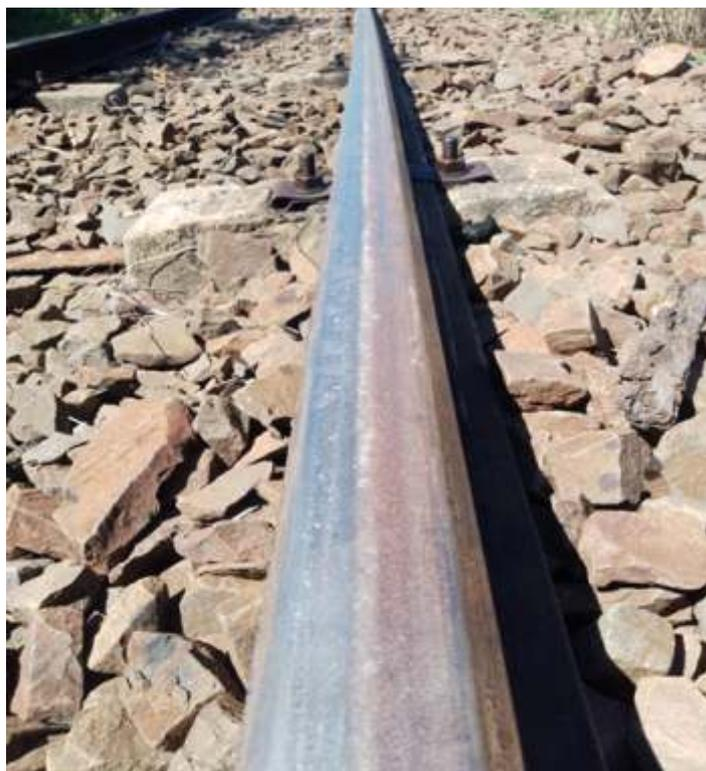
♦ Detalhe do trilho já virado com o lado desgastado do lado de fora. Foto HGF.
