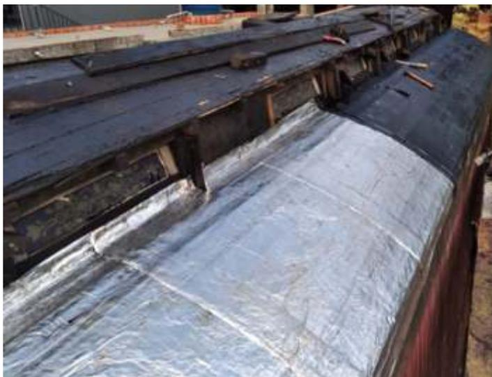
♦ Início da aplicação da manta asfáltica de 3,0mm na parte lateral do teto do carro #1032.
