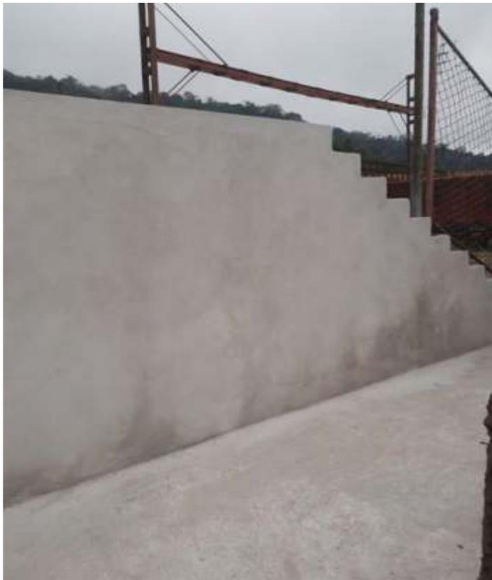
♦ Aplicação inicial de selante para uma melhor fixação da tinta a ser aplicada.
