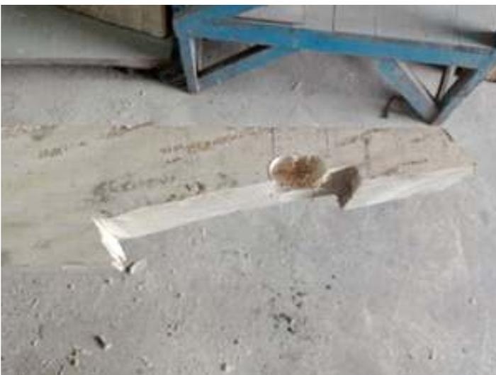
◆ Detalhes do encaixe entre peças da viga superior, esta executada na nova peça em madeira.
