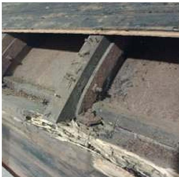
♦ Detalhe da madeira da viga superior completamente comprometida por insetos xilófagos.
