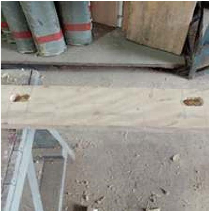
◆ Detalhe dos encaixes da nova peça em madeira maciça que será instalada como "viga superior".
