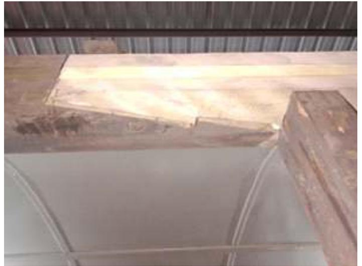
◆ Detalhe do perfeito encaixe entre a peça antiga e a nova, refazendo a viga superior.
