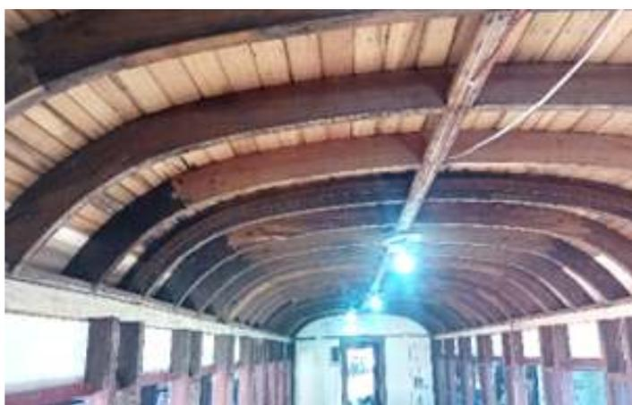
♦ *Desmontagem e remoção da chaparia metálica de revestimento interior do teto.*
