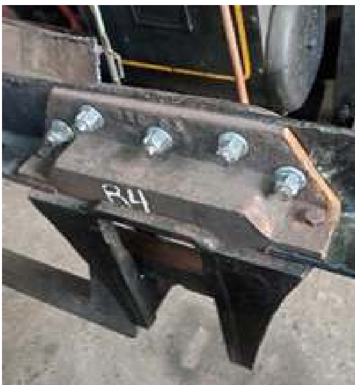
♦ Outra vista da instalação dos pedestais (cadeiras).
