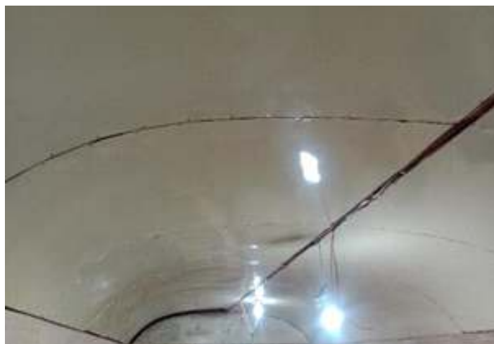
♦ Chaparia do teto já pintada em côr creme e instalada.
