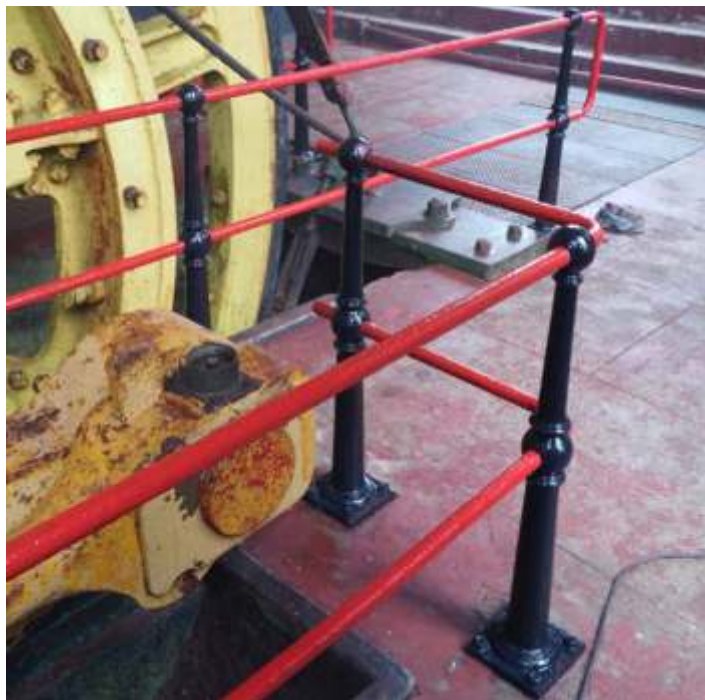
♦ Manutenção nos guarda-corpos da 4ª Machina.
