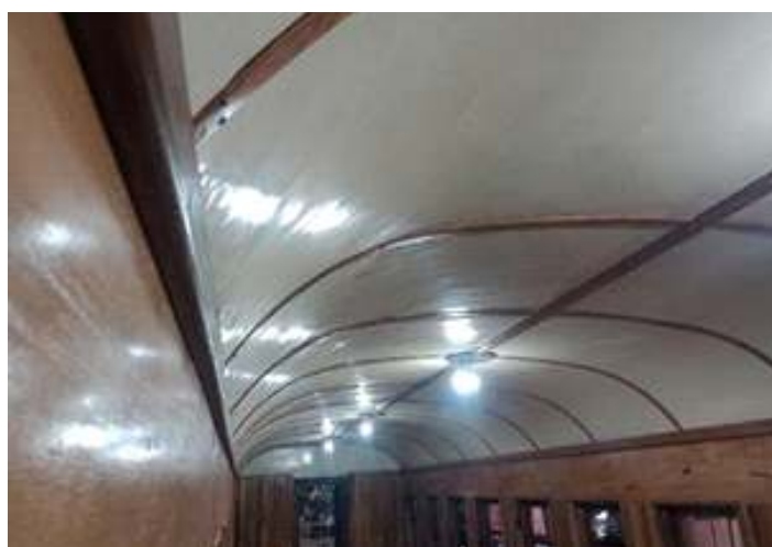
♦ Etapa de instalação das mata-juntas.
