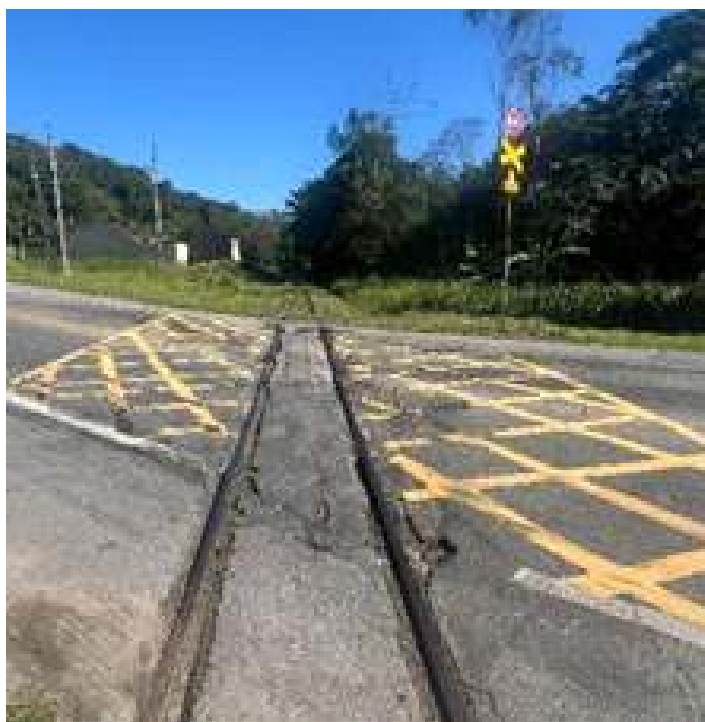
♦ Aspecto da passagem em nível antes da intervenção.
