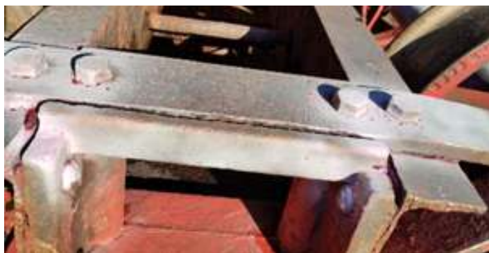
♦ Inspeção por líquido penetrante na armação dos truques do tender da locomotiva Mogul 11.
