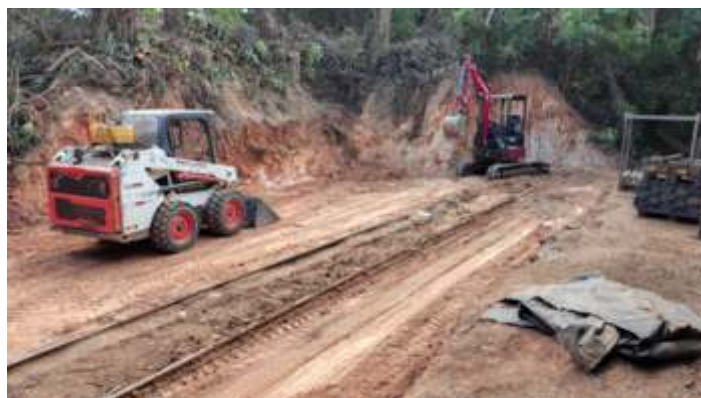
♦ Finalizando o serviço de terraplanagem. Foto HGF.
