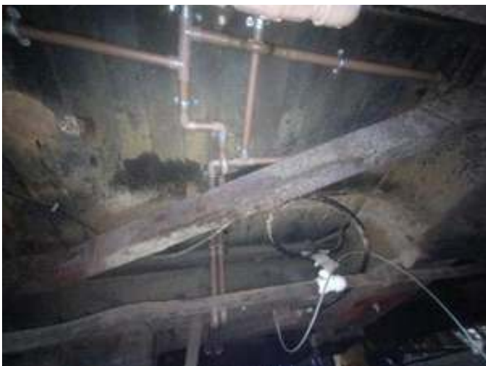
♦ Nova tubulação de água já instalada.
