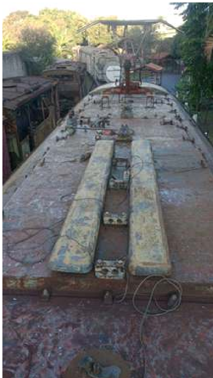
♦ O teto da V8 após lixamento, já sem a antiga pintura.
