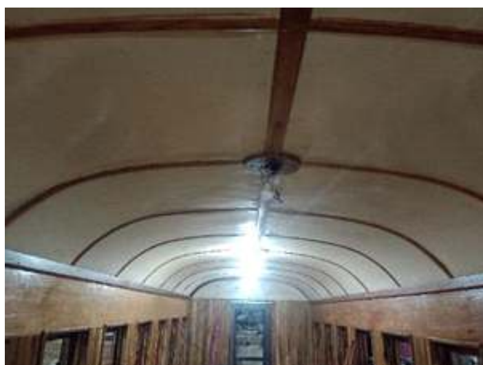
♦ Aspecto do teto, com as mata-juntas já instaladas.
