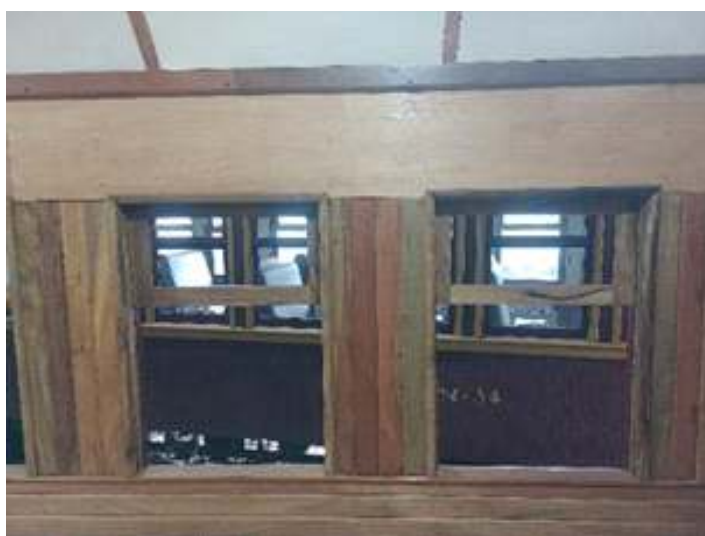
♦ Aspecto do exterior e interior, da etapa de instalação das janelas bandeira (fixas).
