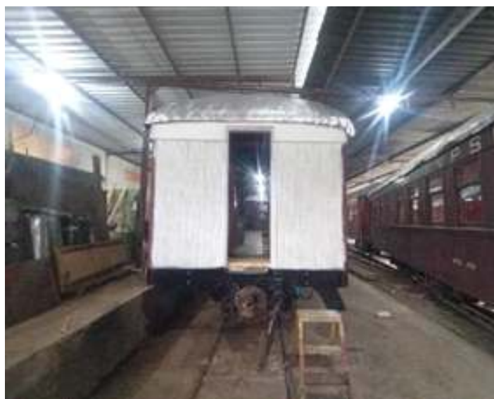
♦ Aspecto da cabeceira A, com ripamento refeito.
