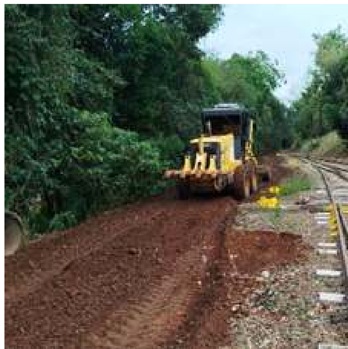
♦ Etapa de abertura do local, criando estrada de acesso para caminhões.
