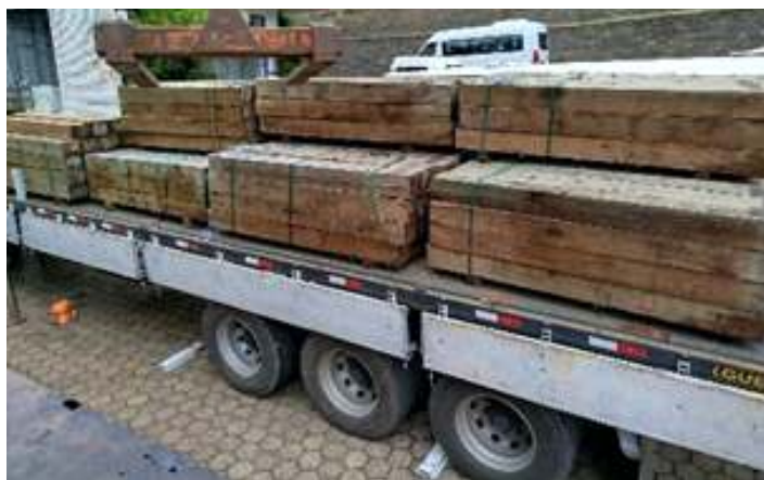
♦ Recebimento de dormentes de madeira para emprego ao longo da via.
