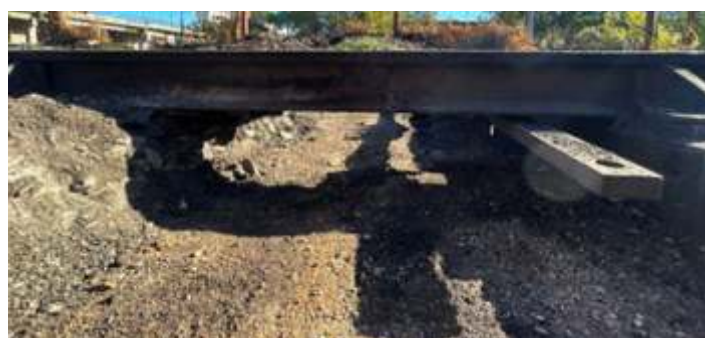
♦ Substituição dos dormentes do AMV que acessa o desvio dos carros de passageiros.
