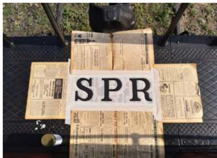
♦ Preparação e empapelamento do local a ser pintado. Foto: Rafael Massini.
