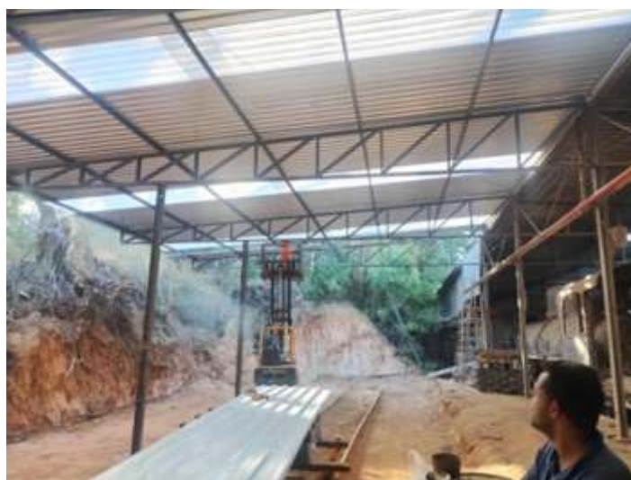
♦ Estrutura pronta recebendo as telhas. Foto HGF.
