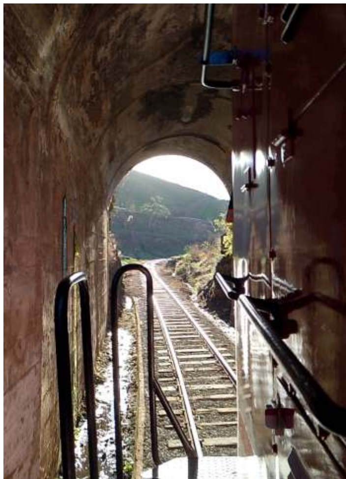
♦ Momento da travessia do túnel nº1.
