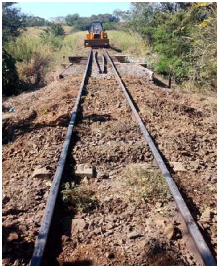
♦ Serviços de substituição de dormentes. Foto Márcio Silva.
