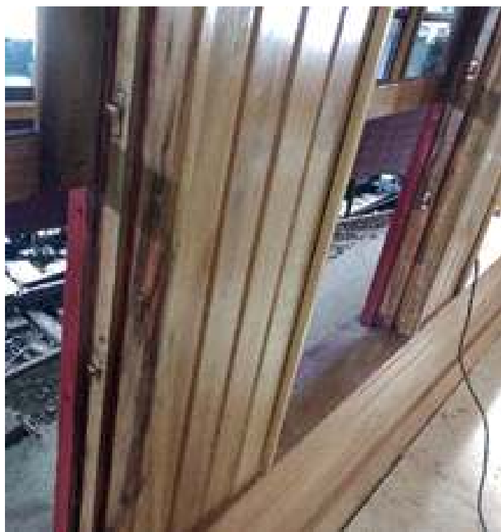
♦ Ripamento de acabamento e trilhos das janelas já instalados.
