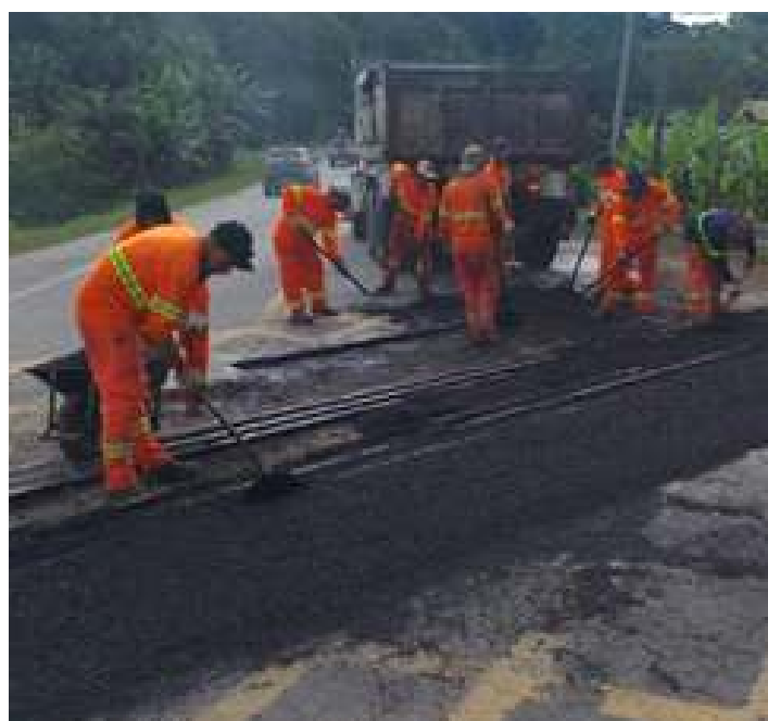
♦ Etapa de reconstrução asfáltica.
