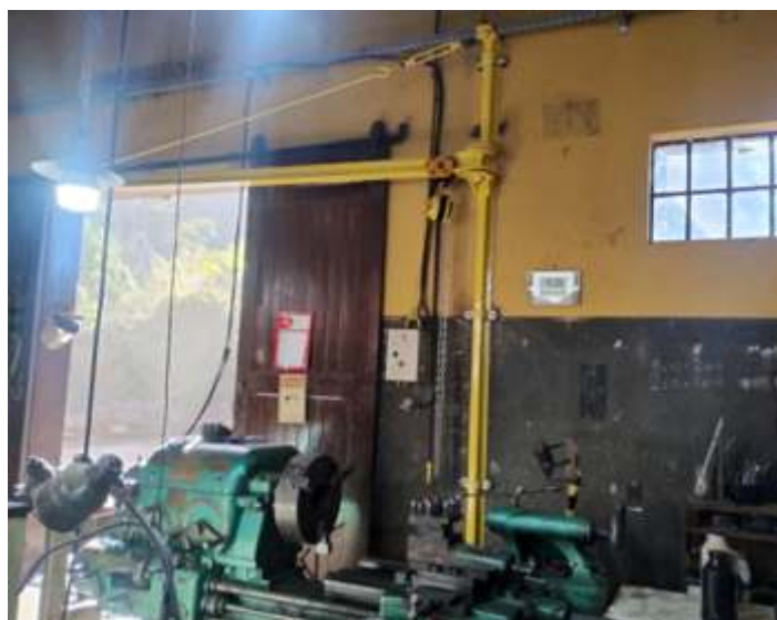
♦ Pórtico instalado na oficina mecânica. Foto HGF.
