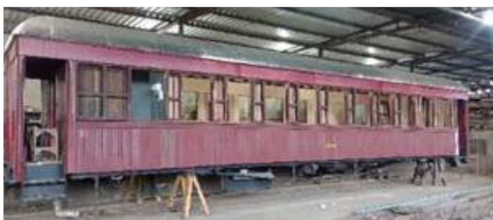
♦ Vista externa do carro de passageiros PD-64, já com a manta asfáltica instalada. nota-se a ausência de truques, conforme descrito anteriormente.
