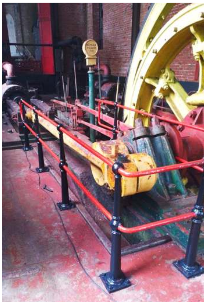
♦ Manutenção nos guarda-corpos da 4ª Machina.
