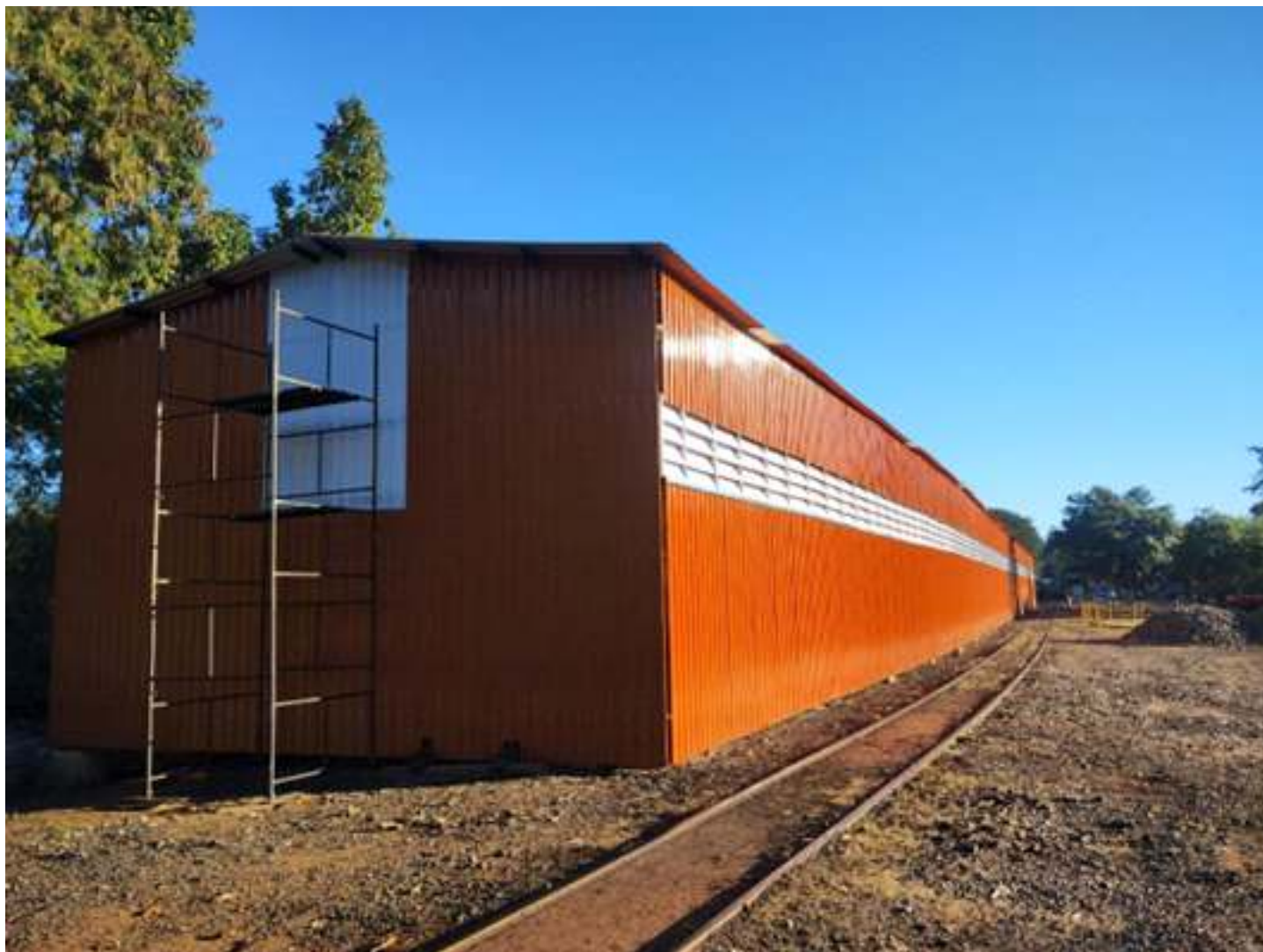
♦ Fechamento da parte de trás do museu ferroviário de Anhumas. Foto HGF.
