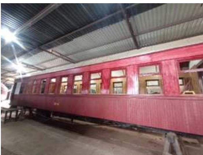
♦ Aspecto da lateral do carro, com o ripamento feito.
