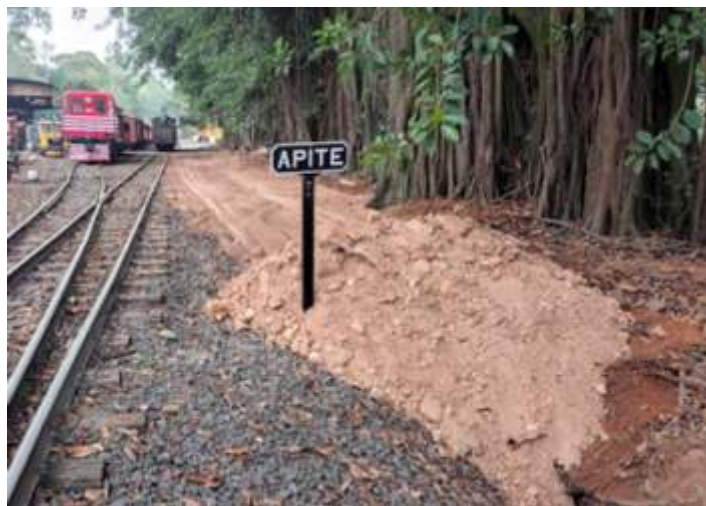
♦ Fazendo o aterro da nova tubulação de água. Foto HGF.
