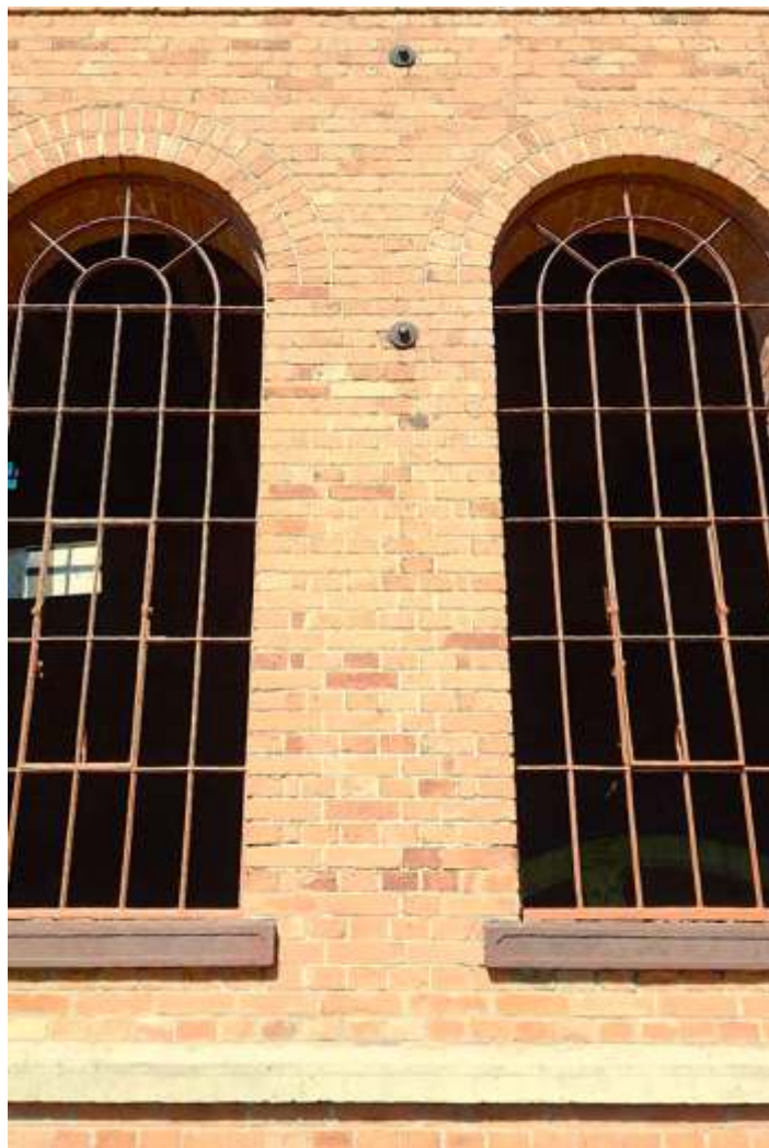
♦ Janelas já sem os vidros, e após raspagem da estrutura de aço para retirada de ferrugem; detalhe da alvenaria limpa, livre das patologias antes existentes. Foto: Alexandre A. Pisciotano.
