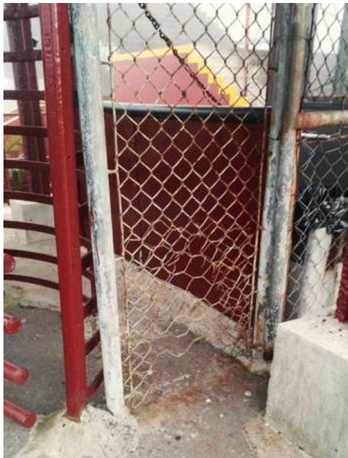
♦ Grades na bilheteria de acesso ao museu após os reparos.
