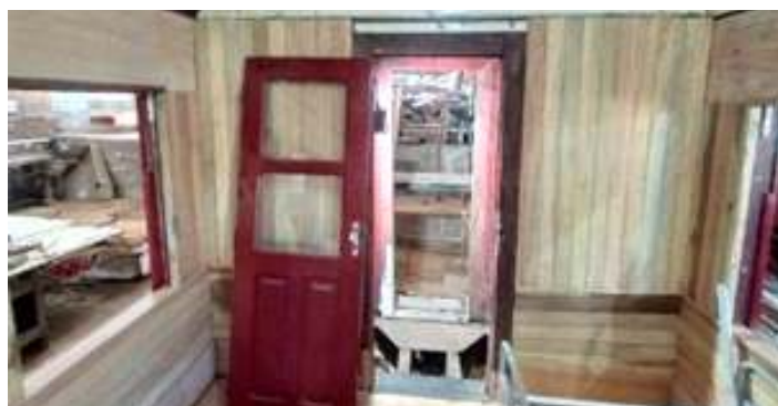
♦ Aspecto das duas cabeceiras do carro, com ripamento e chaparias já instalados.
