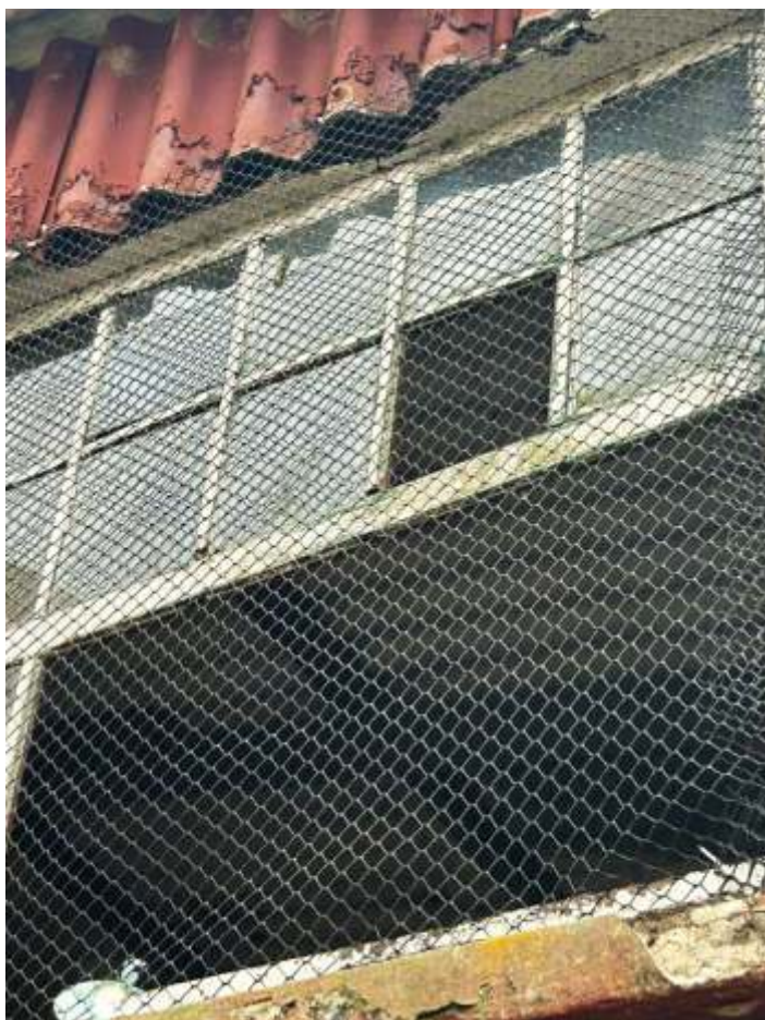
♦ Instalação de telas nas janelas do museu.
