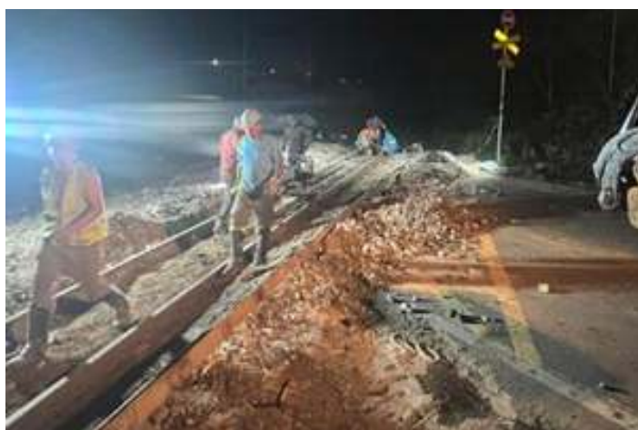
♦ Intervenção na passagem em nível.
