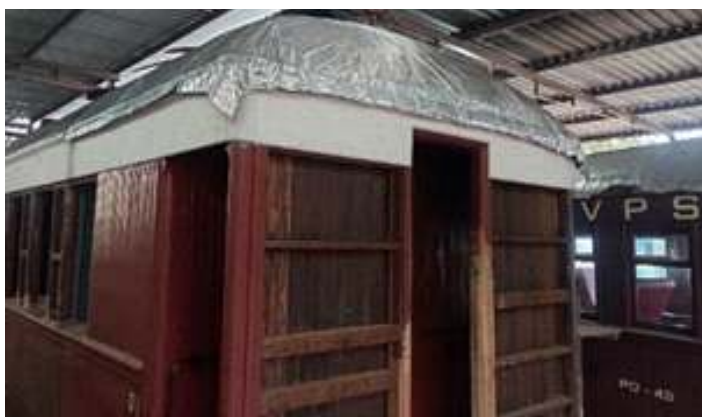
♦ Aspecto do carro durante aplicação da manta asfáltica.
