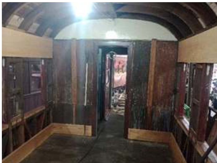
♦ Etapa de início de instalação de madeiramento interior.
