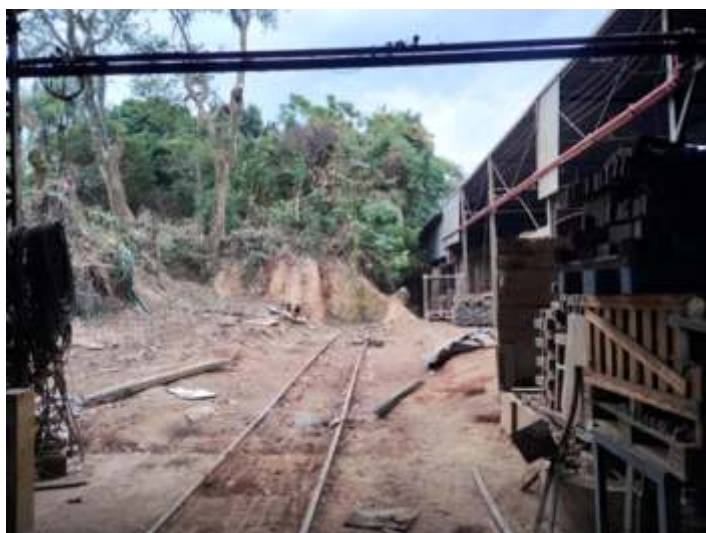
♦ Vista após a retirada do velho galpão de madeira. Foto HGF.
