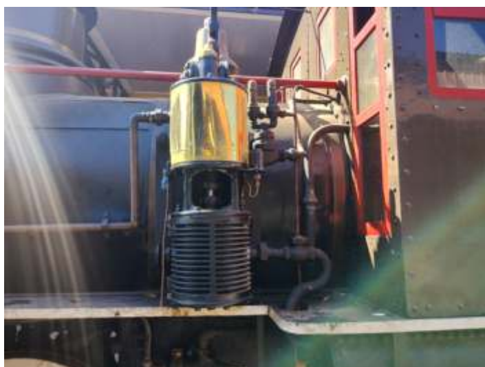
♦ Compressor reformado instalado na loc. 604. Foto HGF.
