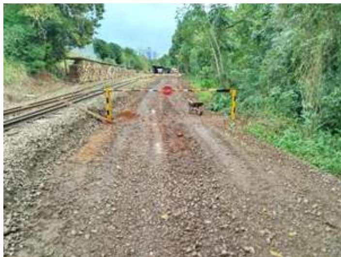
♦ Aspecto do mesmo local após o fim dos serviços.
