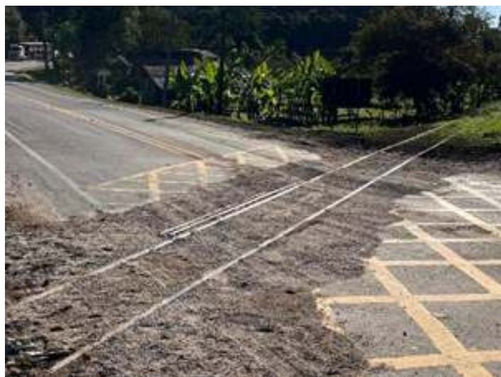
♦ Aspecto da passagem em nível após o fim da intervenção.
