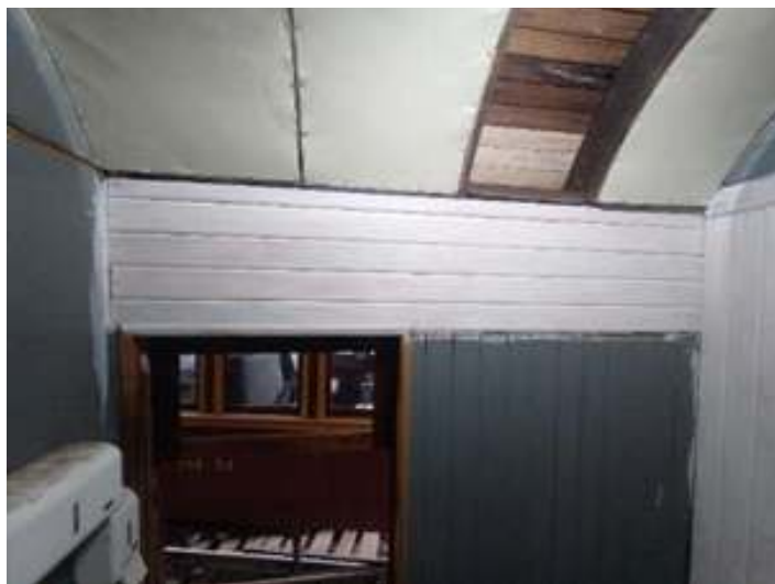
♦ Chaparia do teto do lavabo já pintada e instalada.
