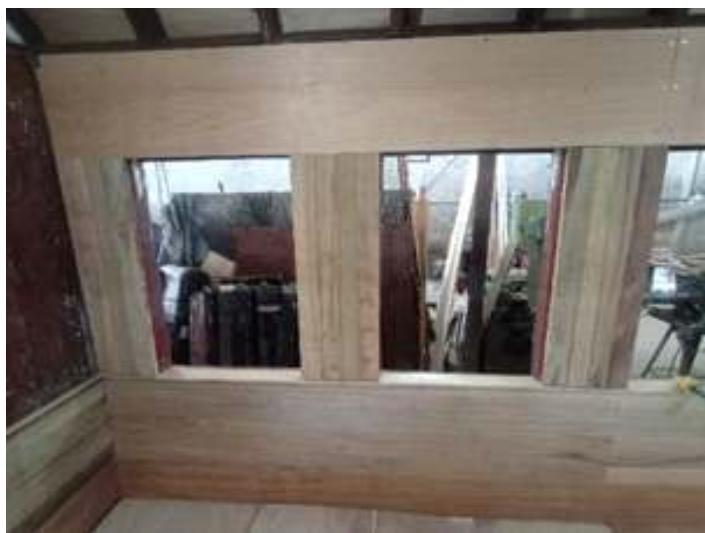
♦ Instalação de rimapento interior praticamente finalizado.
