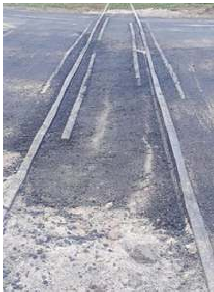
♦ Aspecto final da passagem em nível, após a reposição asfáltica.
