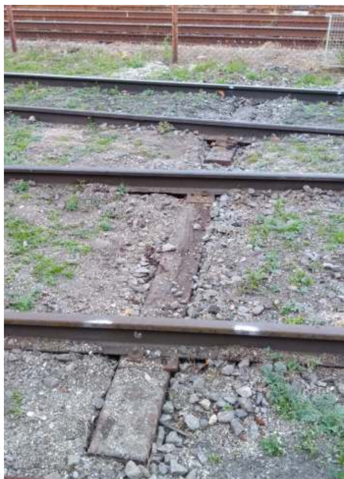
♦ Serviço de substituição de dormentes.
