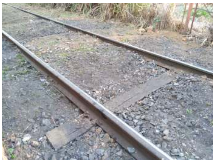
♦ Serviço de substituição de dormentes.
