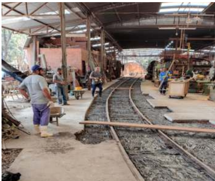
♦ Com a malha de aço, para receber o novo concreto.
