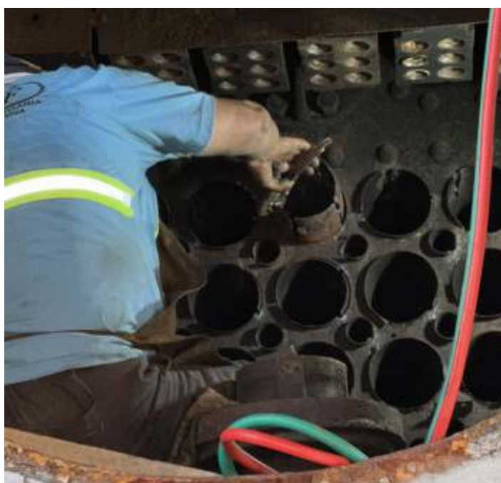
♦ Etapa de remoção dos tubos da caldeira da locomotiva.
