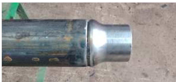
♦ Etapa de soldagem das peças de “fechamento de bocas” dos tubos de 5”.
