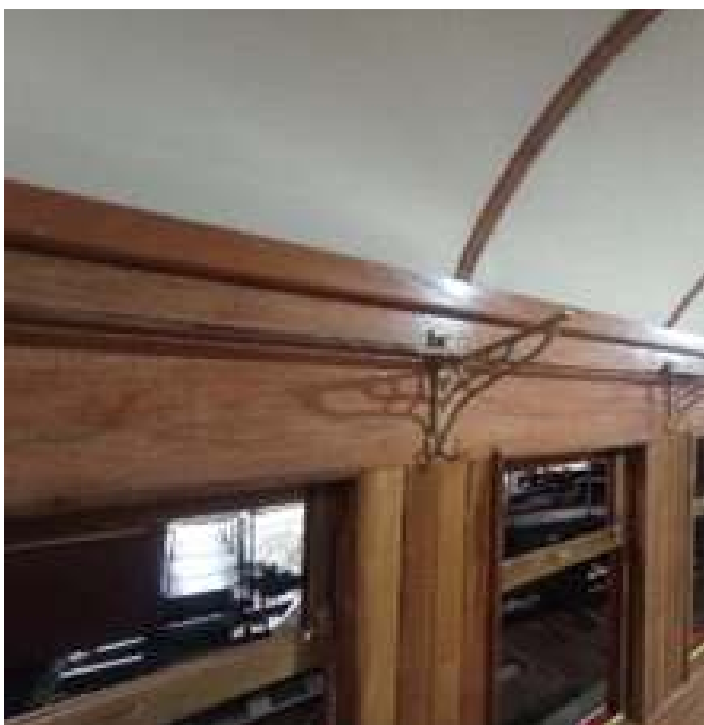
♦ Aspecto do interior do carro PD-64 com o madeiramento interior finalizado e envernizado – nota-se as bases dos maleiros já instalados.
