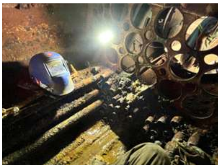
♦ Etapa de remoção dos tubos da caldeira da locomotiva.
