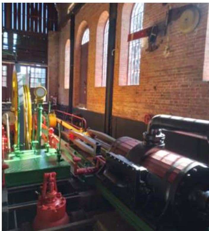
♦ Aspectos da 4ª Machina após a manutenção.
