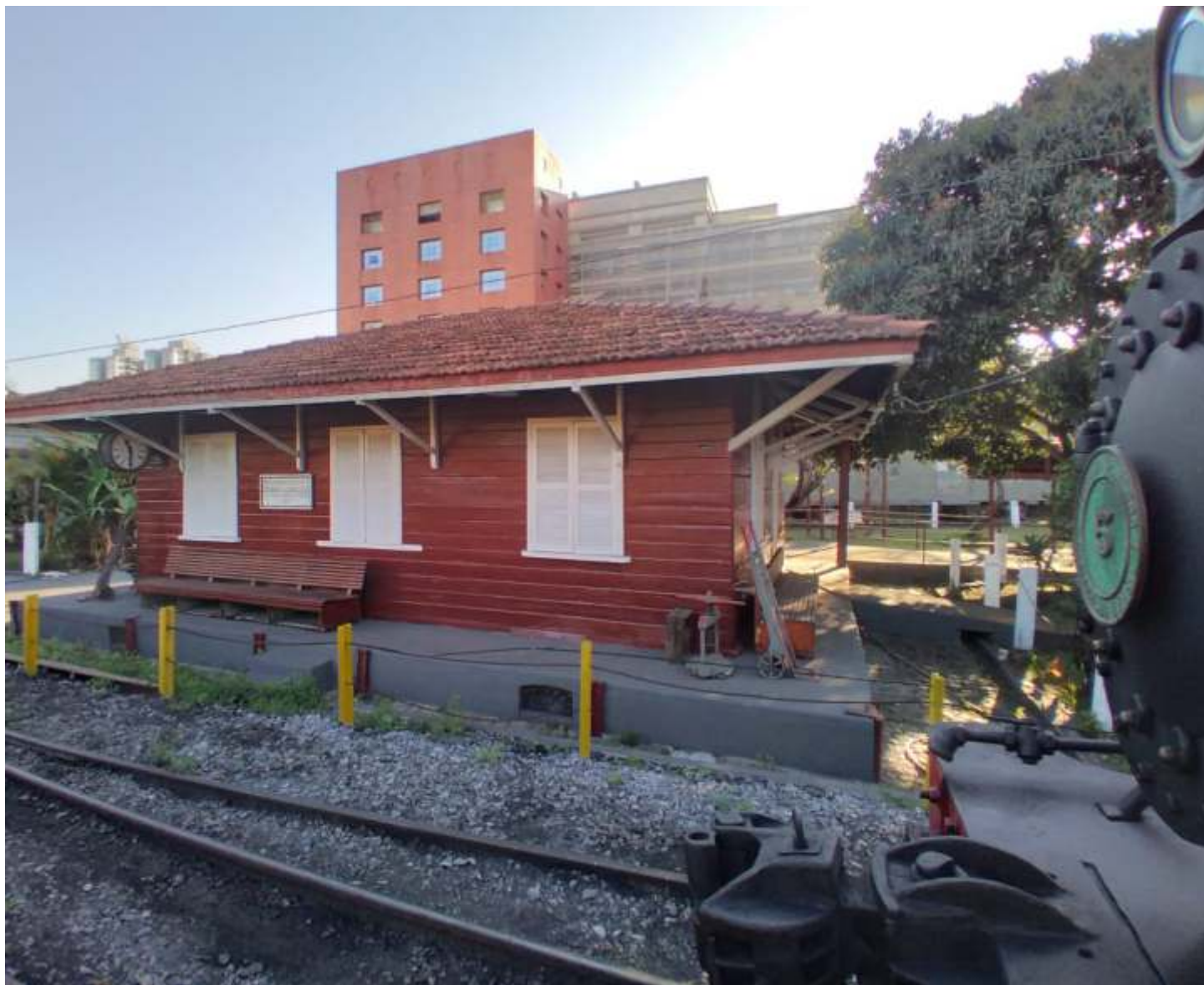
♦ A bela casa de 1908 construída pela SPR com sua nova pintura. Foto: Alexandre A. Pisciotano.
