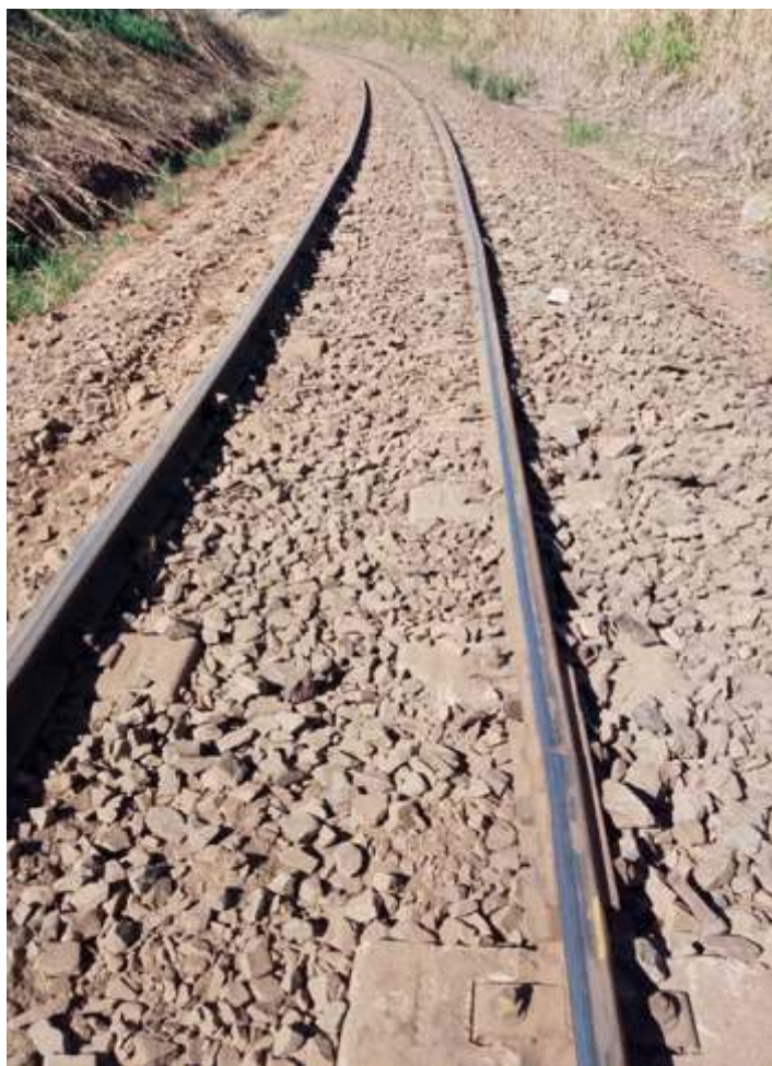
♦ Trecho em curva, em remodelação, após passar reguladora de lastro. Foto de Márcio Silva.
