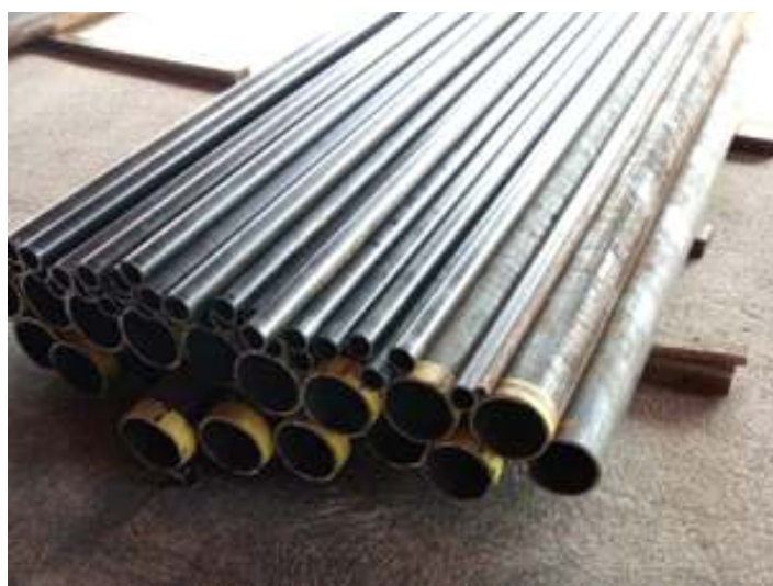
♦ Os novos tubos da caldeira selecionados, cortados e prontos para instalação.
