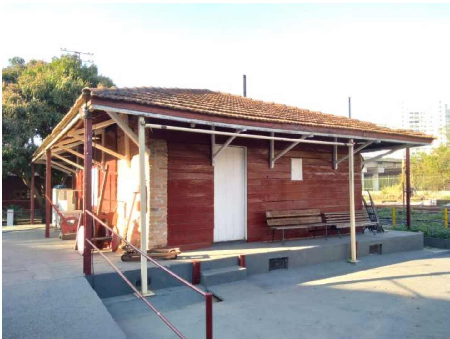
♦ Outras vistas da bela casa de madeira construída em 1908 pela SPR com sua nova pintura. Fotos: Alexandre Pisciotano.
