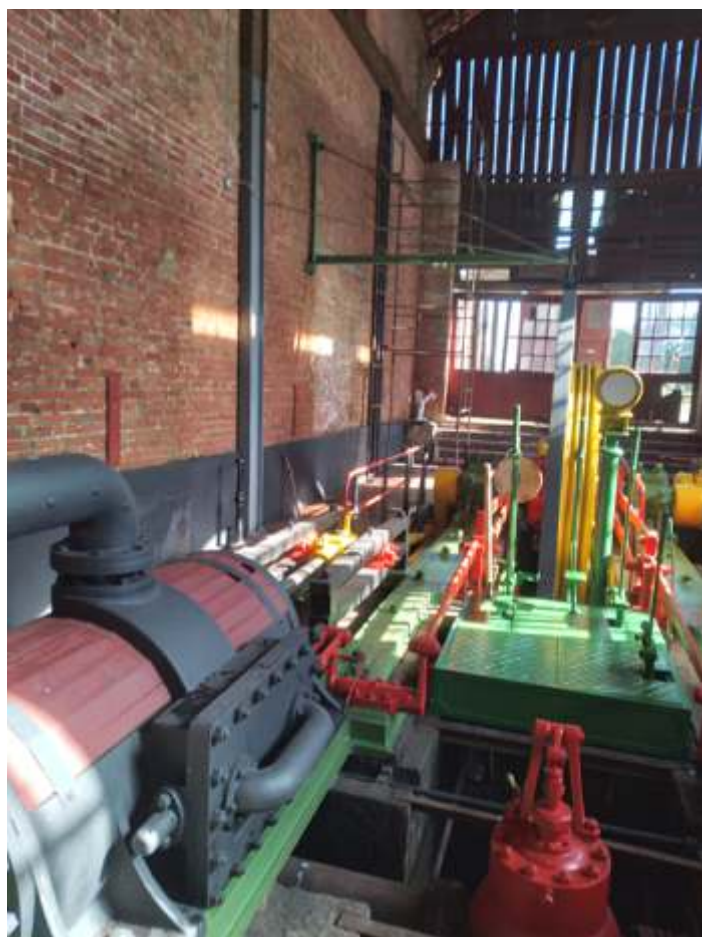
♦ Aspectos da 4ª Machina após a manutenção.
