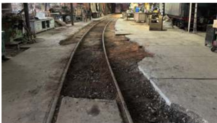
♦ Retirada do concreto para reforço da via. Foto HGF.
