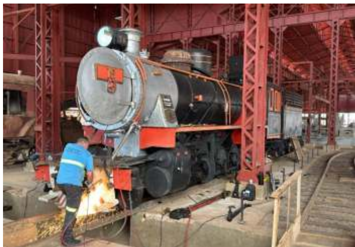
♦ Remoção do limpa trilhos para início dos trabalhos na roda guia.
