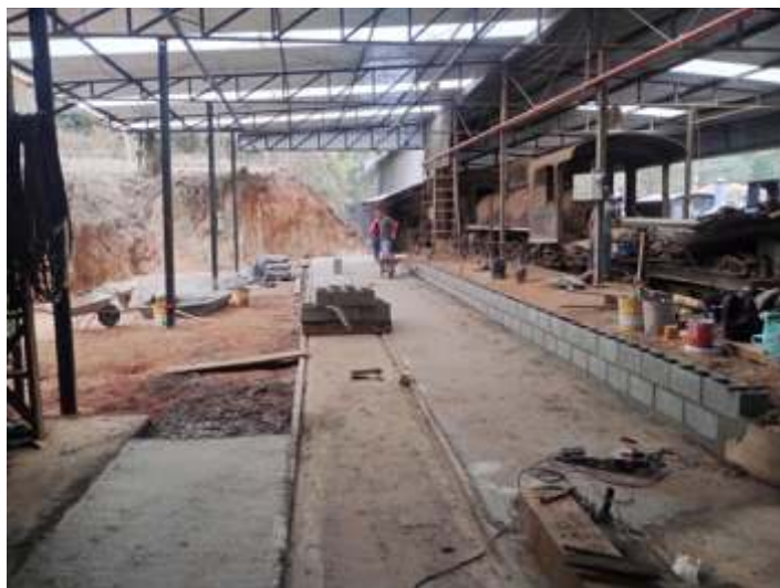
♦ Nova cobertura e serviços de paredes e piso. Foto HGF.
