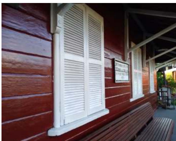
♦ Detalhes da casa de madeira construída pela SPR em 1908 após receber a nova pintura: além da melhoria estética e valorização do bem, mais proteção à estrutura. Fotos: Alexandre A. Pisciotano.
