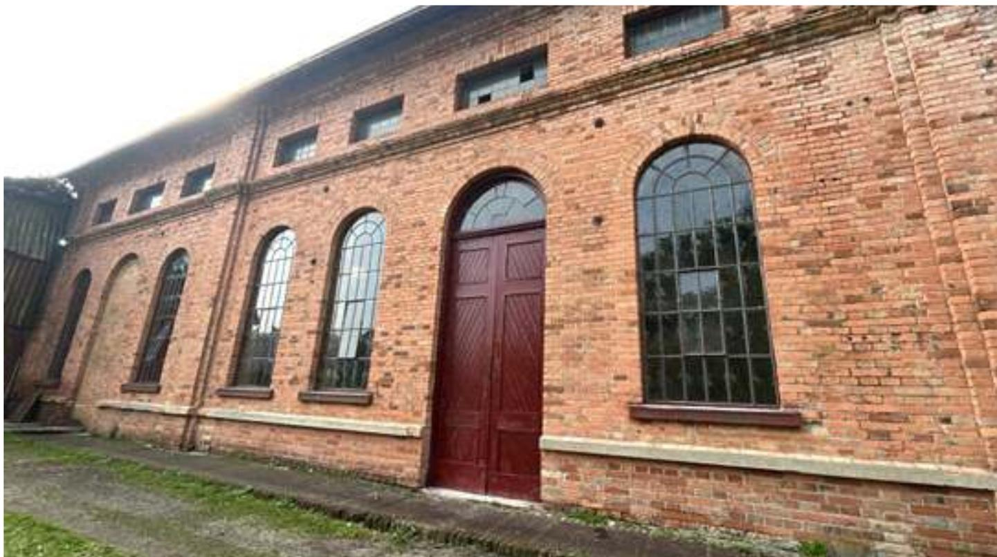
♦ Aspecto geral da fachada lateral após instalação dos novos vidros nas janelas e pintura da porta em vermelho Goya.
