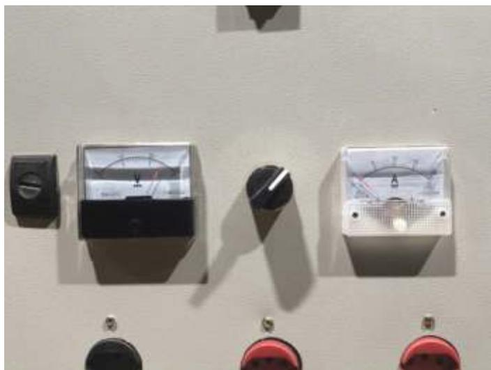
♦ Detalhe de um painel elétrico instalado com opção de 24 volts para testes em componentes de carros de passageiros.
