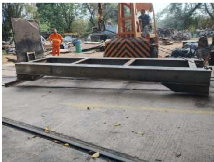
♦ Construção da estrutura metálica do novo pontilhão. Foto de HGF.
