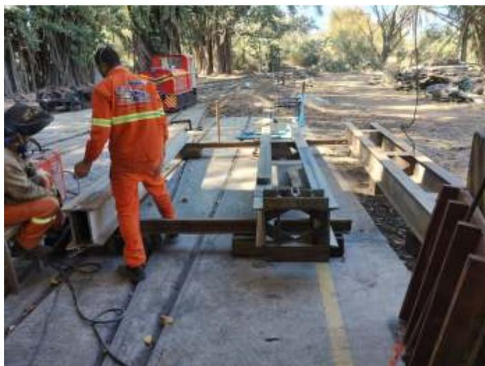
♦ Construção da estrutura metálica do novo pontilhão. Foto de HGF.p
