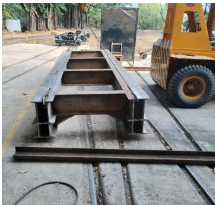
♦ Construção da estrutura metálica do novo pontilhão. Foto de HGF.
