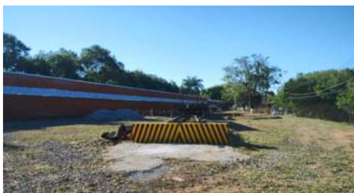
♦ Reparo da mureta do girador e pintura. Foto de HGF.
