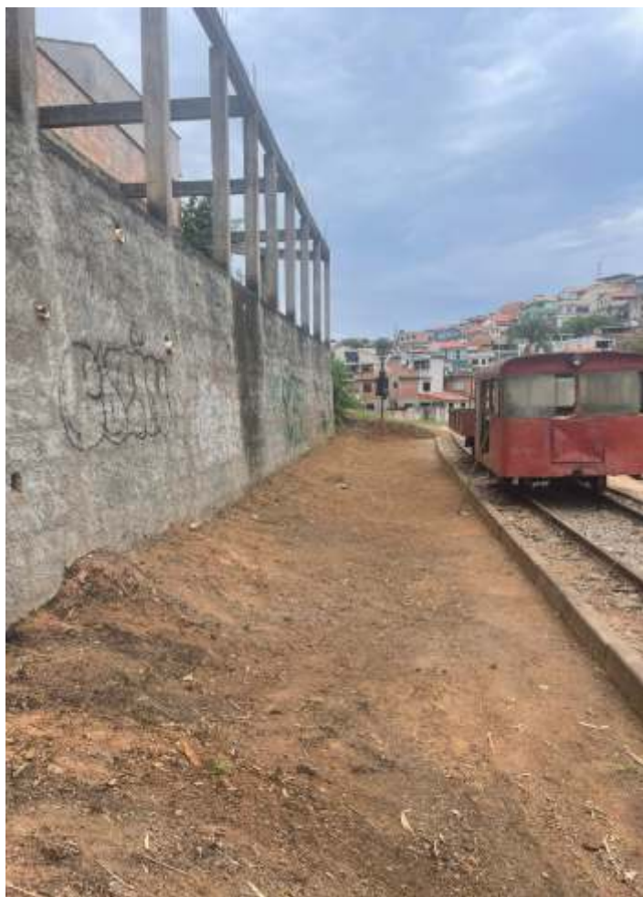
♦ Serviço de limpeza ao longo do km 80.
