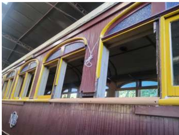
♦ Diversos reparos sendo feitos no carro CA-36. Foto HGF.
