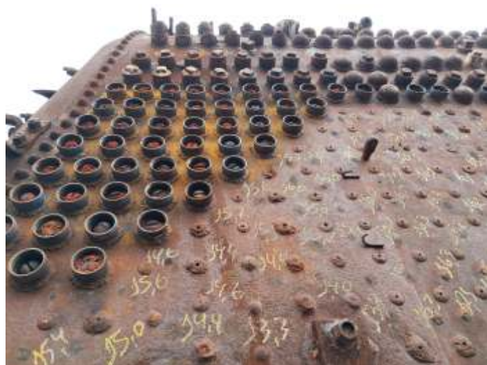
♦ Detalhe de vários tampões já removidos.
