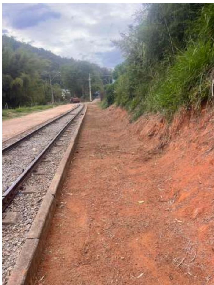
♦ Serviço de limpeza ao longo do km 80.
