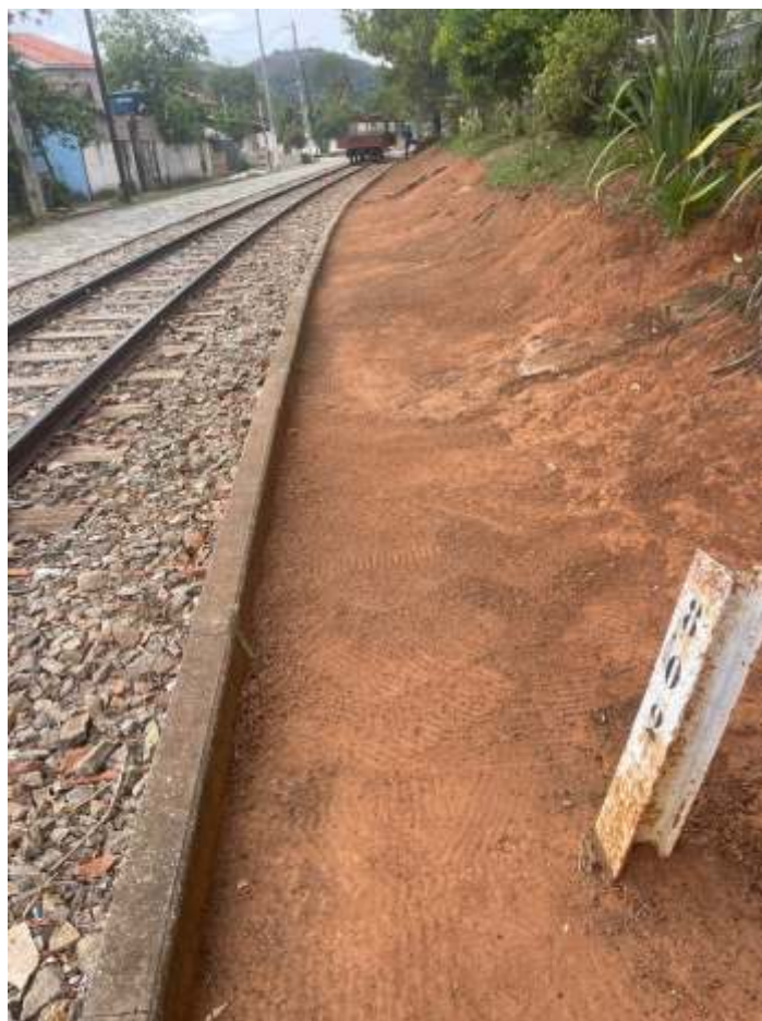
♦ Serviço de limpeza ao longo do km 80.
