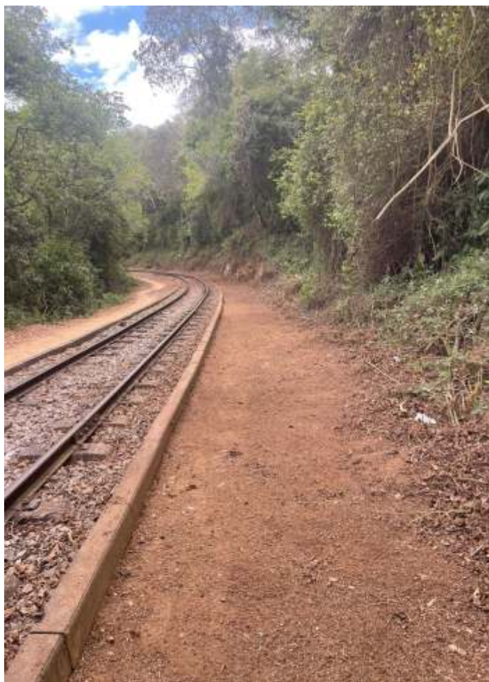
♦ Serviço de limpeza da faixa de domínio.
