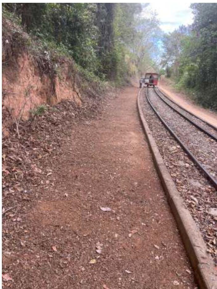
♦ Serviço de limpeza da faixa de domínio.
