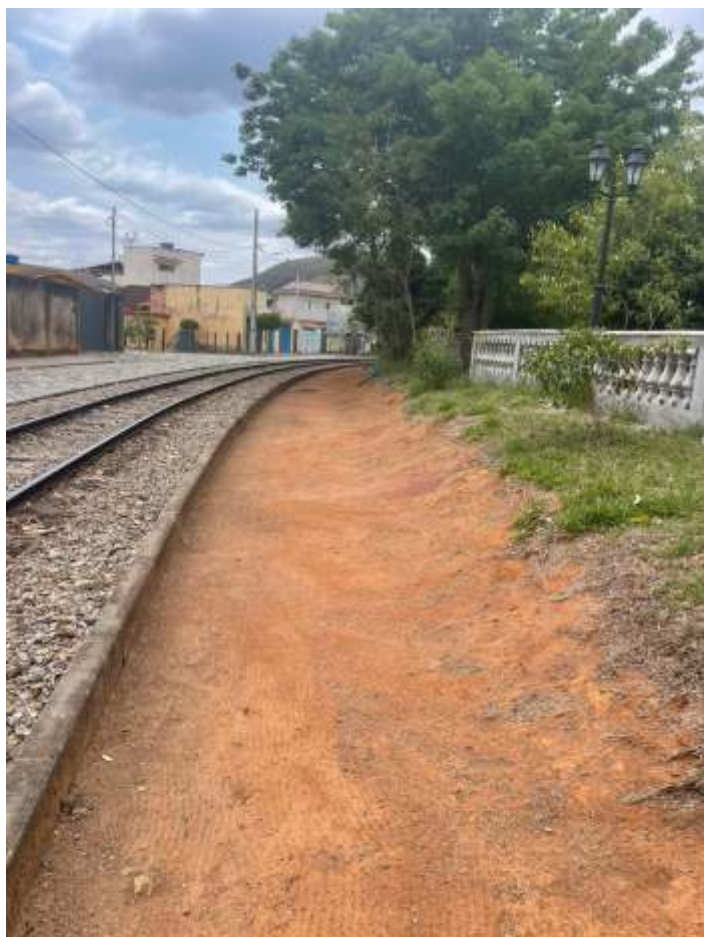
♦ Serviço de limpeza ao longo do km 80.
