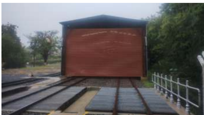
♦ Fachada do Museu Ferroviário, com a nova porta instalada. Foto HGF.
