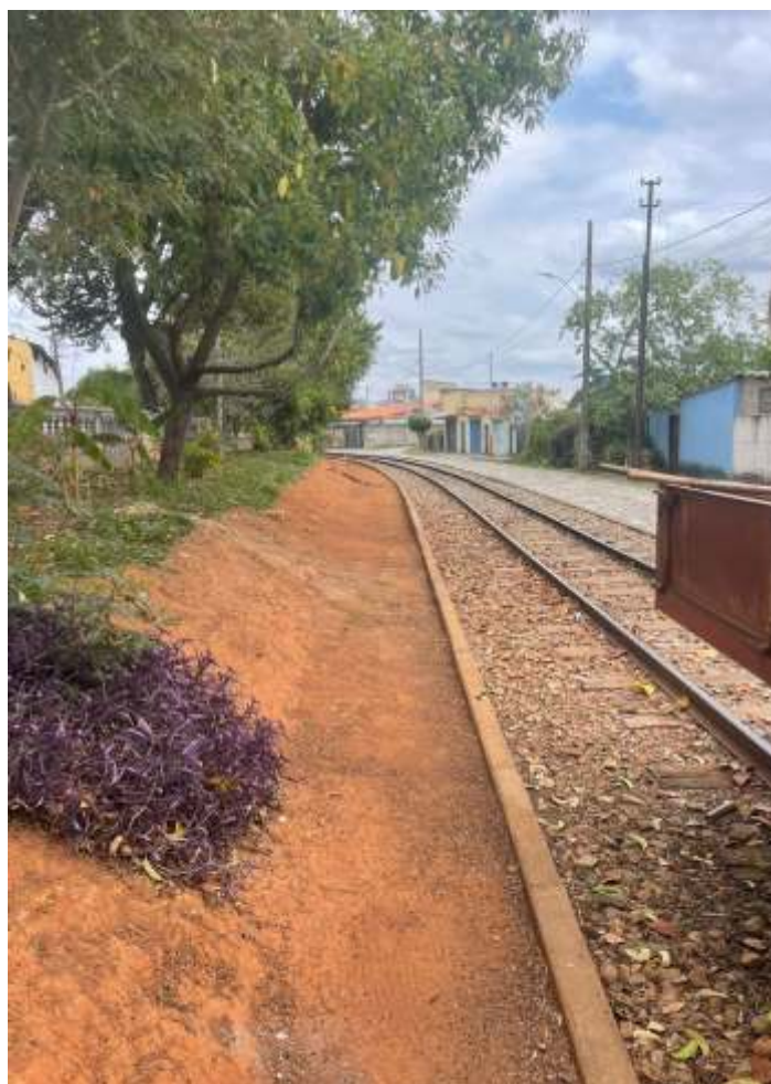
♦ Serviço de limpeza ao longo do km 80.
