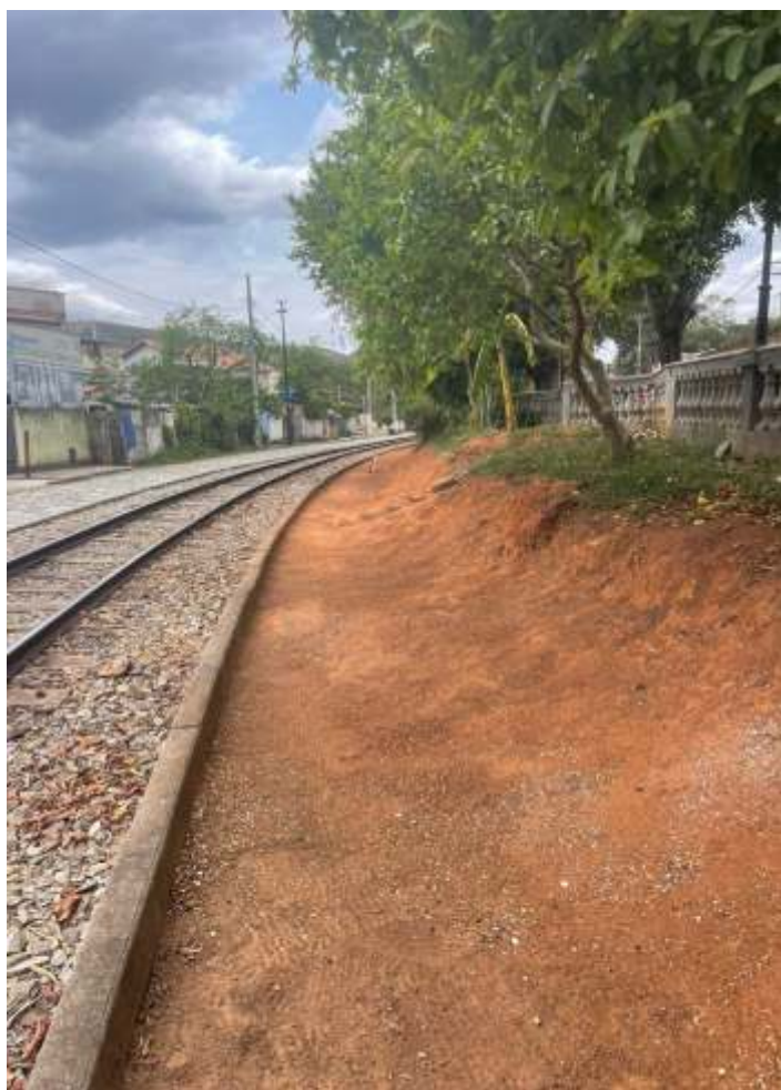
♦ Serviço de limpeza ao longo do km 80.
