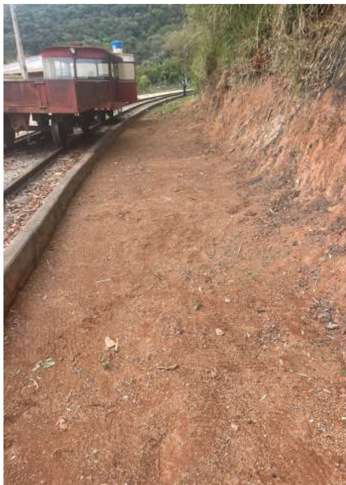
♦ Serviço de limpeza ao longo do km 80.
