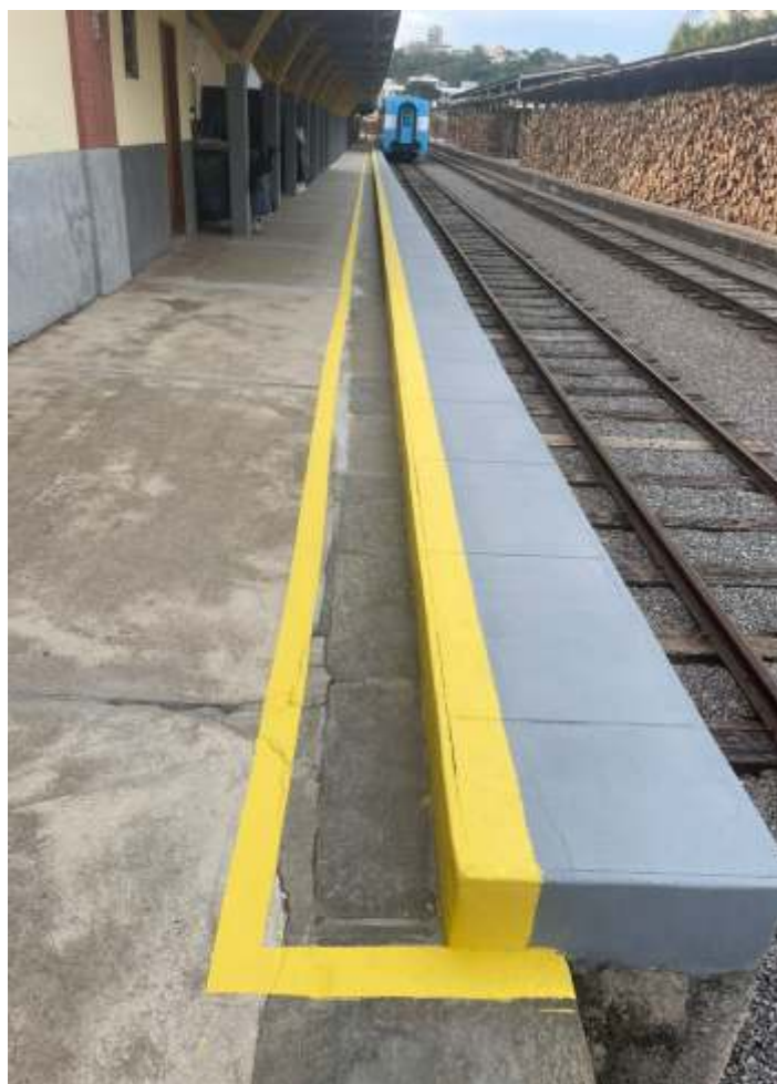
♦ Repintura das faixas de sinalização da plataforma.
