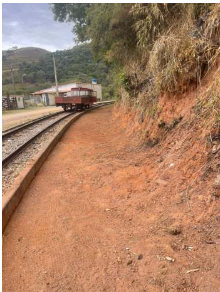
♦ Serviço de limpeza ao longo do km 80.
