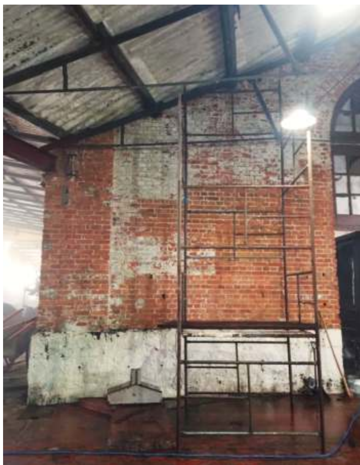
♦ Paredes pós limpeza, conforme recomendação de nossa Arquiteta.
