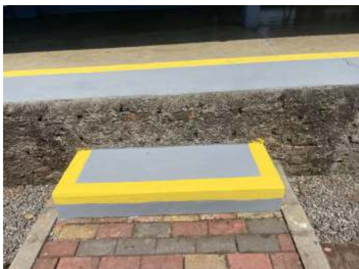
♦ Repintura das faixas de sinalização na estação.
