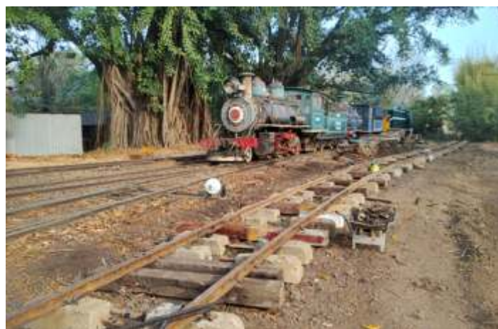
♦ Pequeno ramal sendo construído em CG com sobras de material. Foto HGF.
