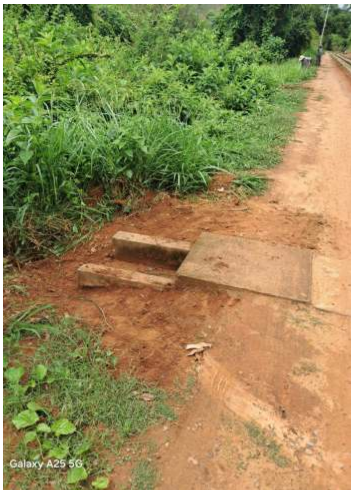
♦ Serviço de limpeza de saída de água pluvial.
