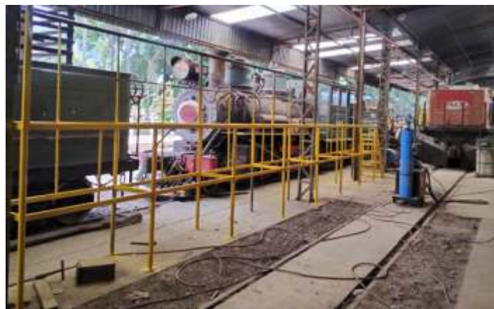
♦ Construção das plataformas para oficina de locomotivas. Foto HGF.
