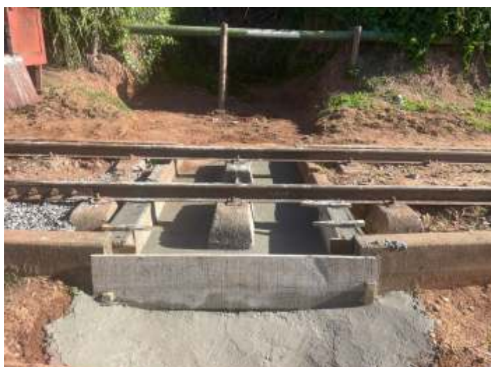
♦ Serviço de recuperação de passagem de água pluvial.
