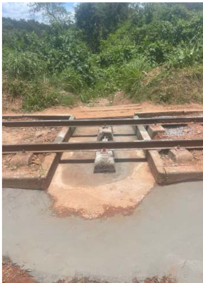
♦ Serviço de recuperação de passagem de água pluvial.
