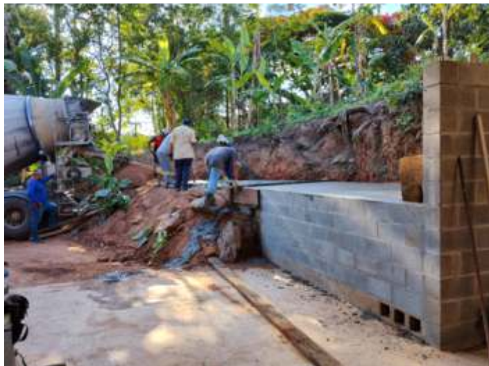
♦ Base para as caixas de água, da água pluvial para lavagem. Foto HGF.
