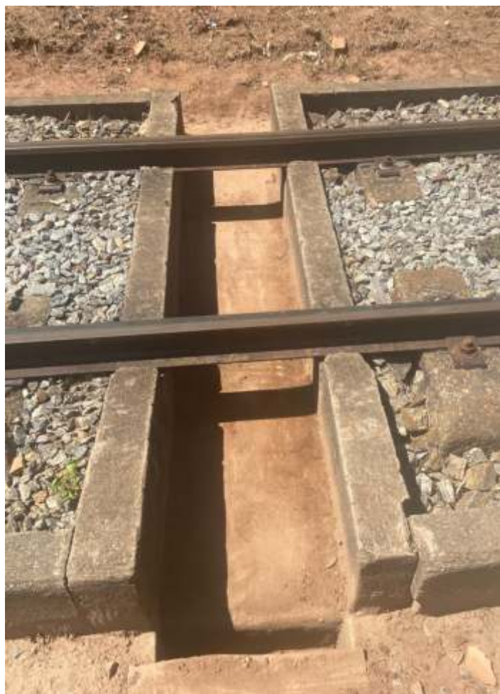
♦ Serviço de limpeza do sistema de drenagem.
