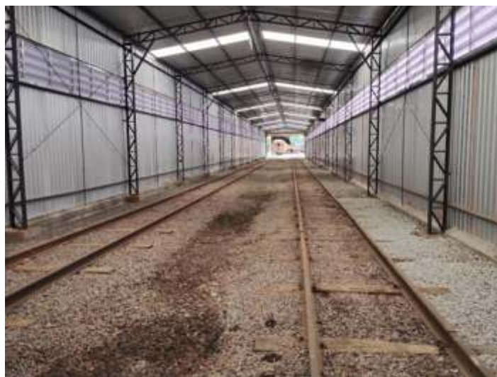
♦ Interior do galpão do museu ferroviário, após fechamento das bordas inferiores. Foto HGF.
