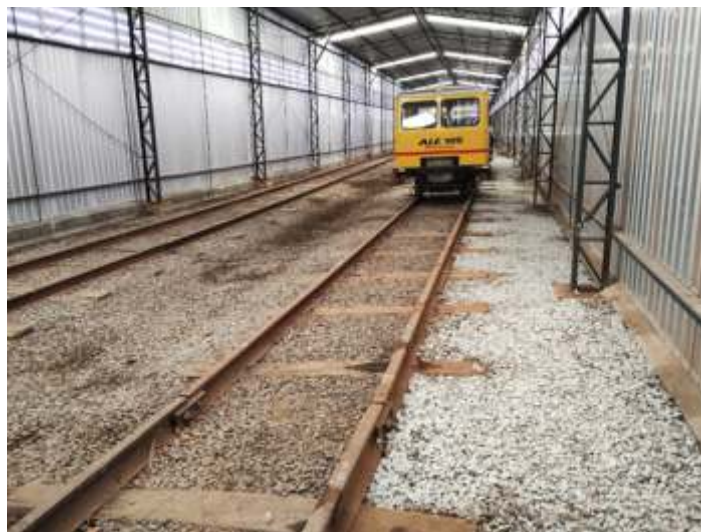
♦ Detalhe do fechamento lateral. Foto de HGF.
