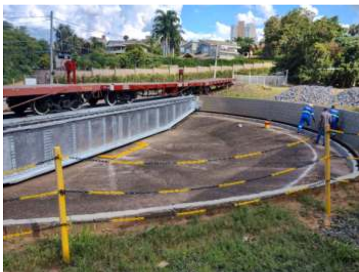
◆ Finalizados os serviços de pintura do girador. Foto HGF.
