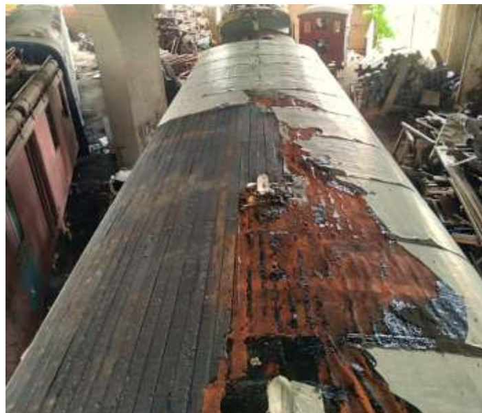
♦ O teto já sem a parte branca (manta asfáltica) e com o início da retirada do antigo madeiramento superior.
