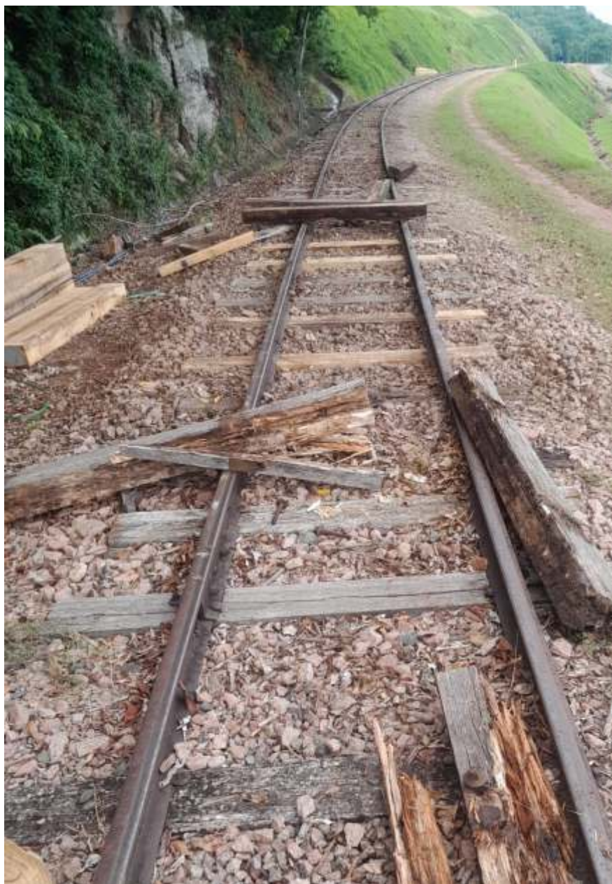
♦ Troca de dormentes ao longo dos 500mts finais do trajeto.
