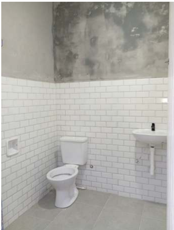
♦ Em processo de finalização, apenas faltando pintura e demais acabamentos para o banheiro masculino.
