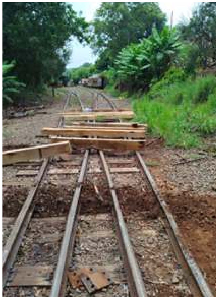
♦ Trabalho de troca de dormentes e nivelamento do amv sul de Piratuba.
