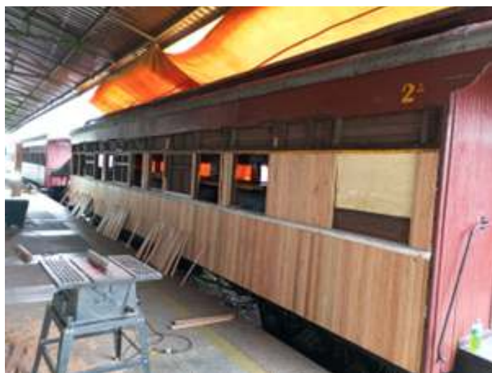
♦ Etapa de instalação do madeiramento nas paredes laterais do carro de passageiros.
