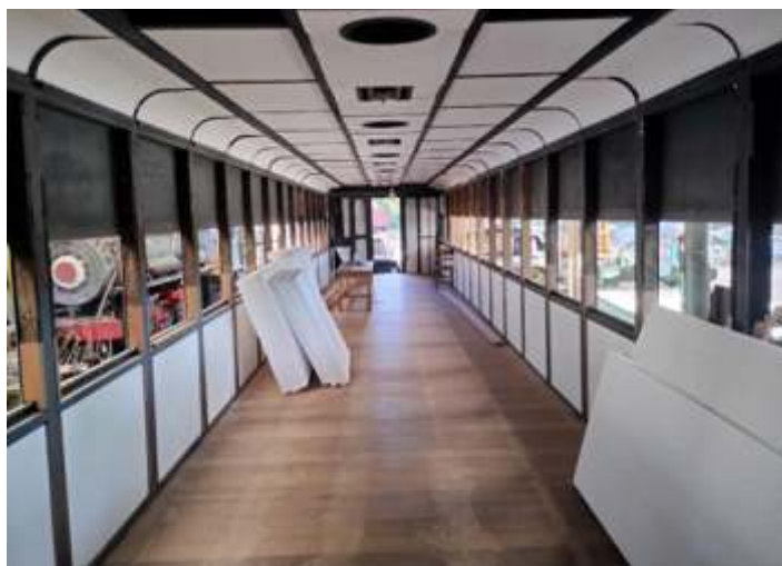
♦ Colocação de placas de isopor, para isolar termicamente.
