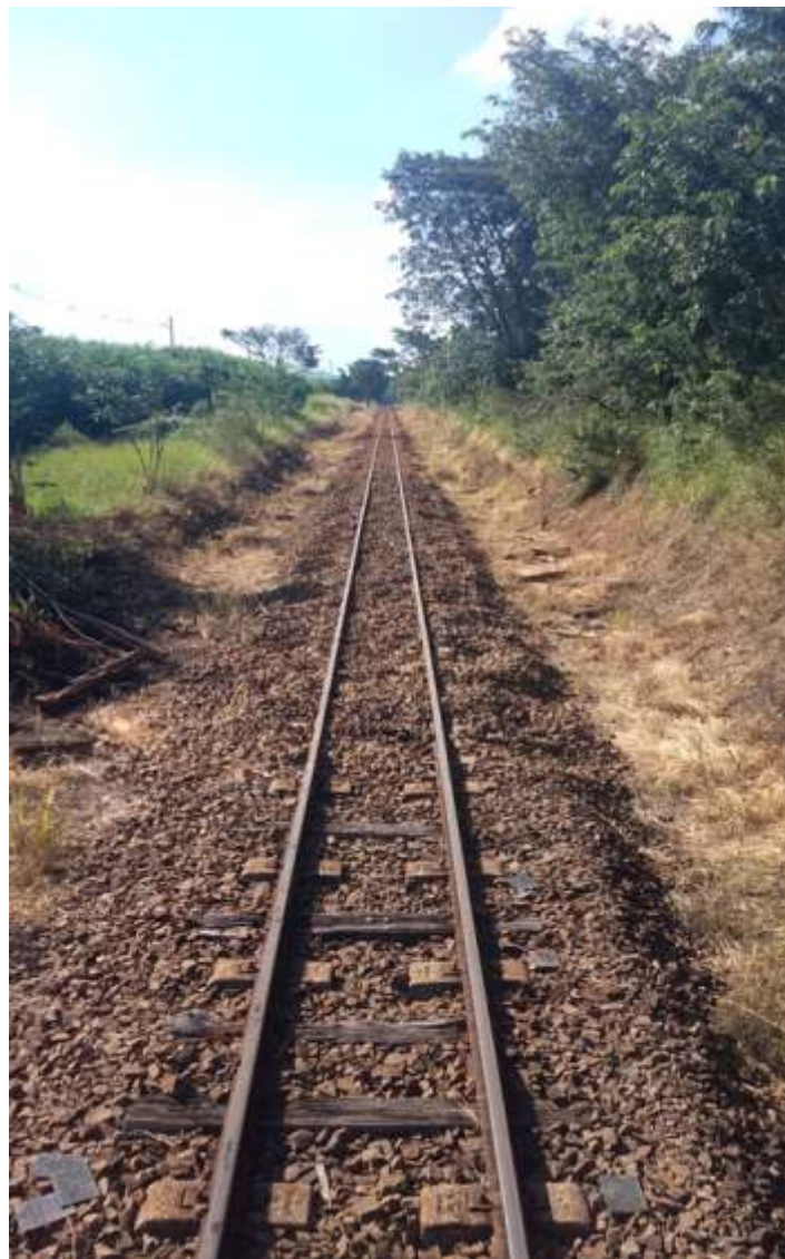
♦ Trecho que está sendo feita a substituição de dormentes. Foto Márcio Silva.
