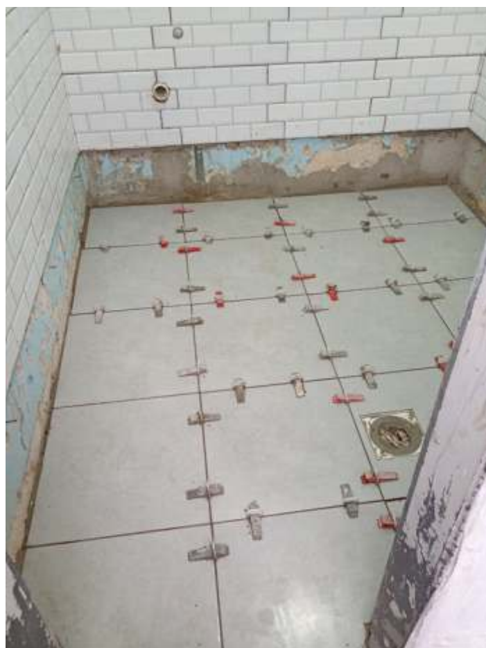
♦ O piso já instalado no banheiro masculino.
