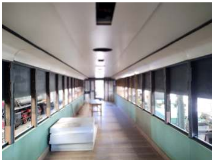
♦ Já com as novas laterais e forro instalado. Foto HGF.
