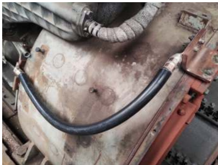
♦ Onde era a barra de cobre que foi furtada do GP, agora é cabo. Foto HGF.
