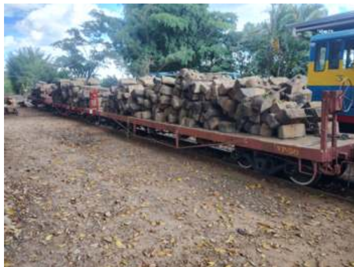
♦ Três vagões carregados totalizando 500 dormentes para serem distribuídos no trecho. Foto HGF.
