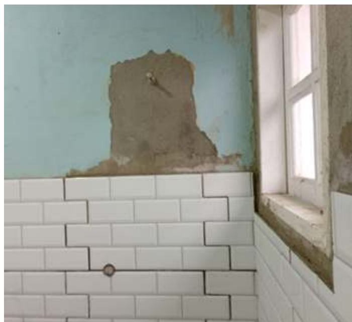
♦ Obras de manutenção dos banheiros da área externa ao Museu.
