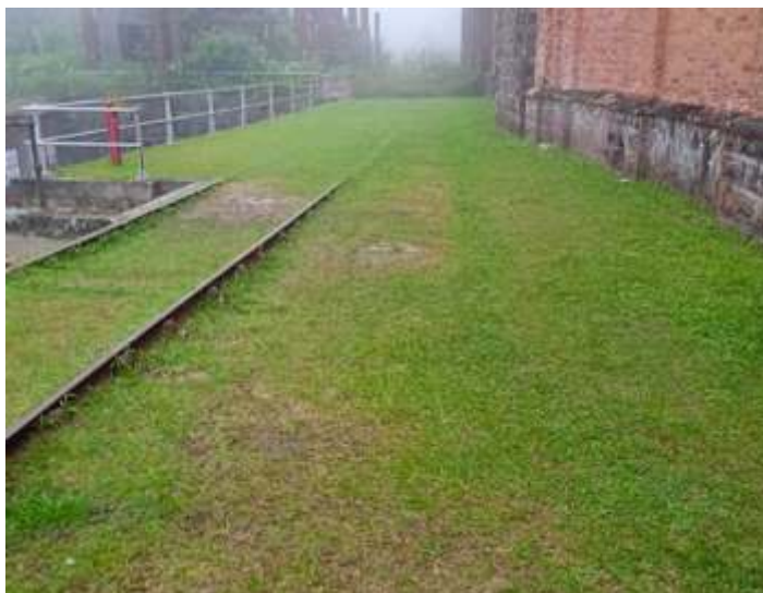
♦ Trabalhos de roçada de mato em toda a área externa do Museu.
