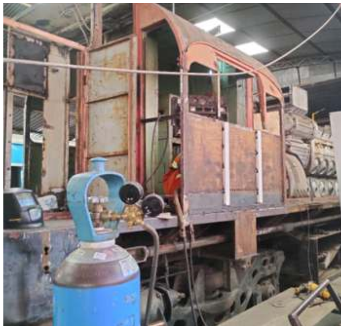
♦ Reparos sendo executados, com novos perfis e parte da chaparia substituída. Foto HGF.
