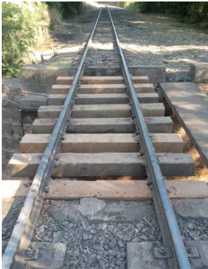
♦ Pontilhão de CG após troca do madeiramento. Foto Márcio Silva.
