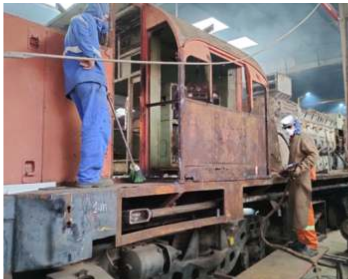
♦ Retirada das chapas velhas da cabina. Foto HGF.
