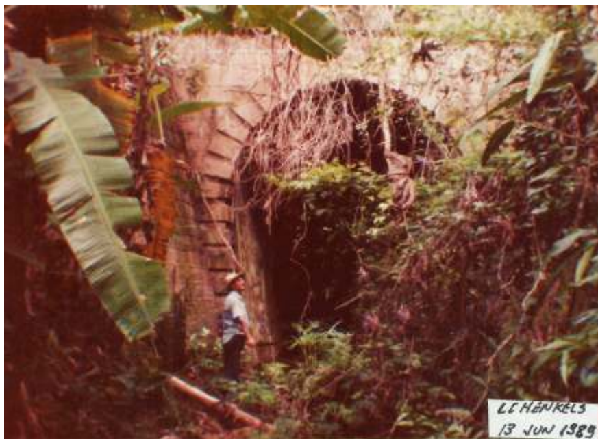
♦ Entrada do túnel em 1989. No detalhe o guia, "Seu Leopoldo", brandindo seu facão, instrumento necessário para acesso à estrutura. Autoria de Luiz Carlos Henkels.
