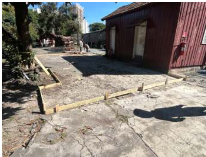
♦ Preparação do piso para recebimento do novo concreto.
