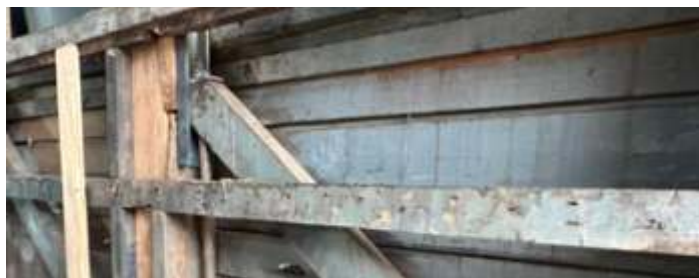
♦ Etapa de melhorias no madeiramento estrutural do carro de passageiros PM-34.
