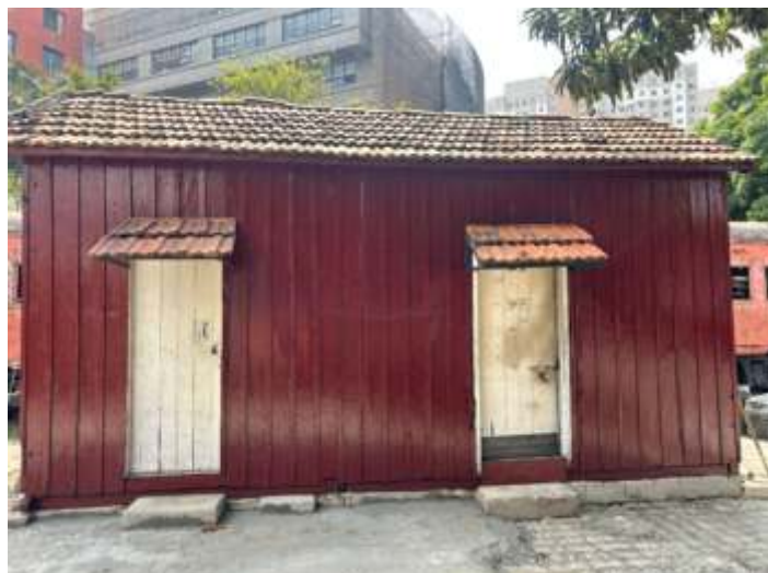
♦ Pintura da antiga casa de ferroviários em andamento.
