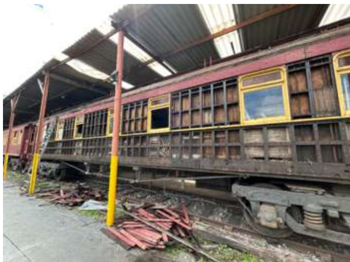
♦ Início dos trabalhos de retirada das madeiras do carro.
