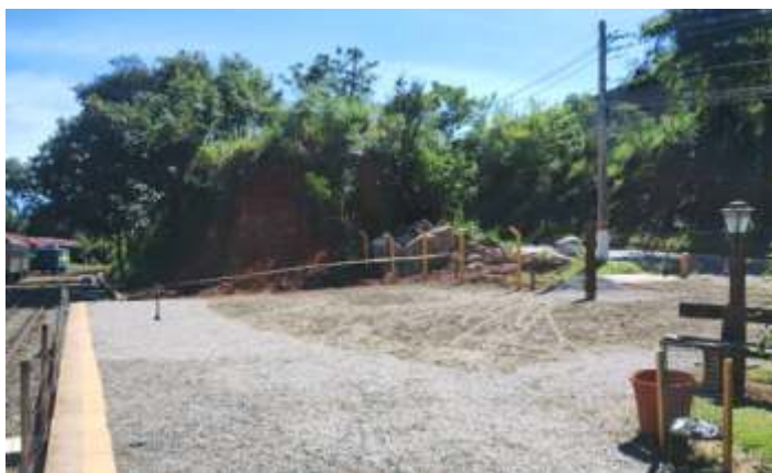
♦ Após conclusão da retirada das raízes. Foto HGF.
