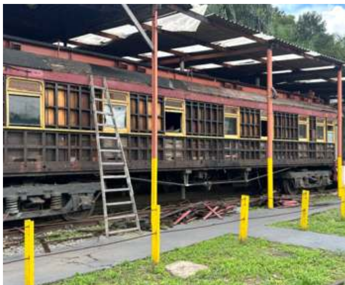
♦ Início dos trabalhos de retirada das madeiras do carro.
