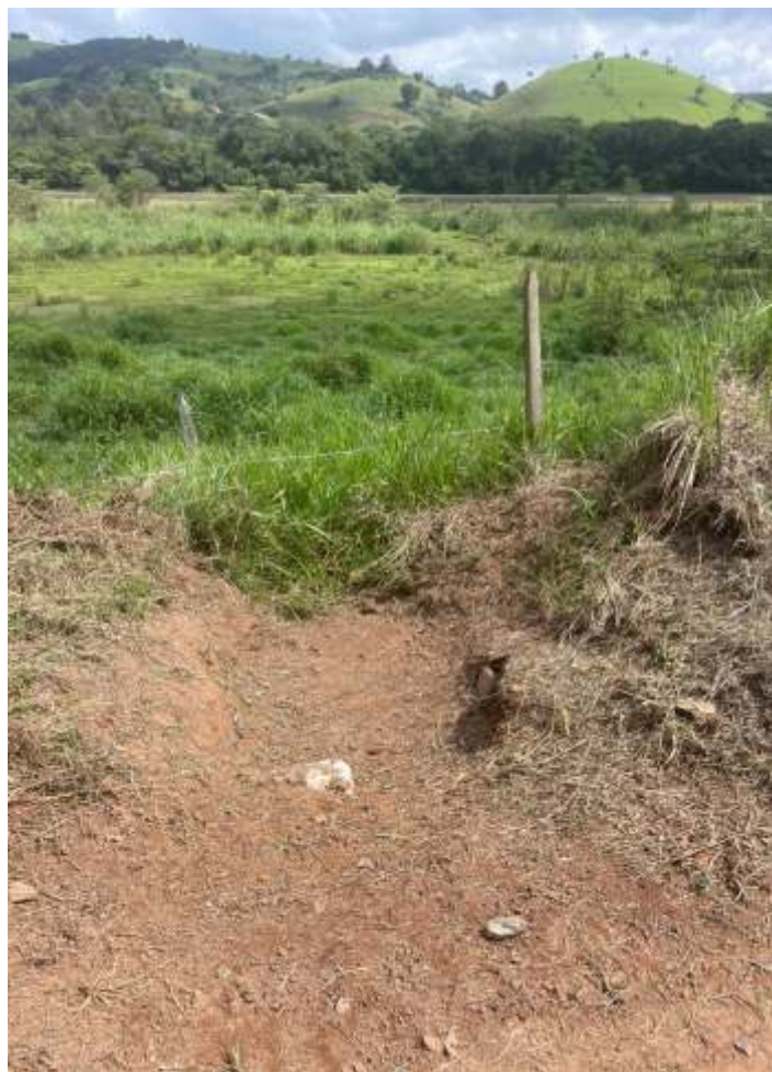
♦ Serviço de limpeza do sistema de drenagem da via.
