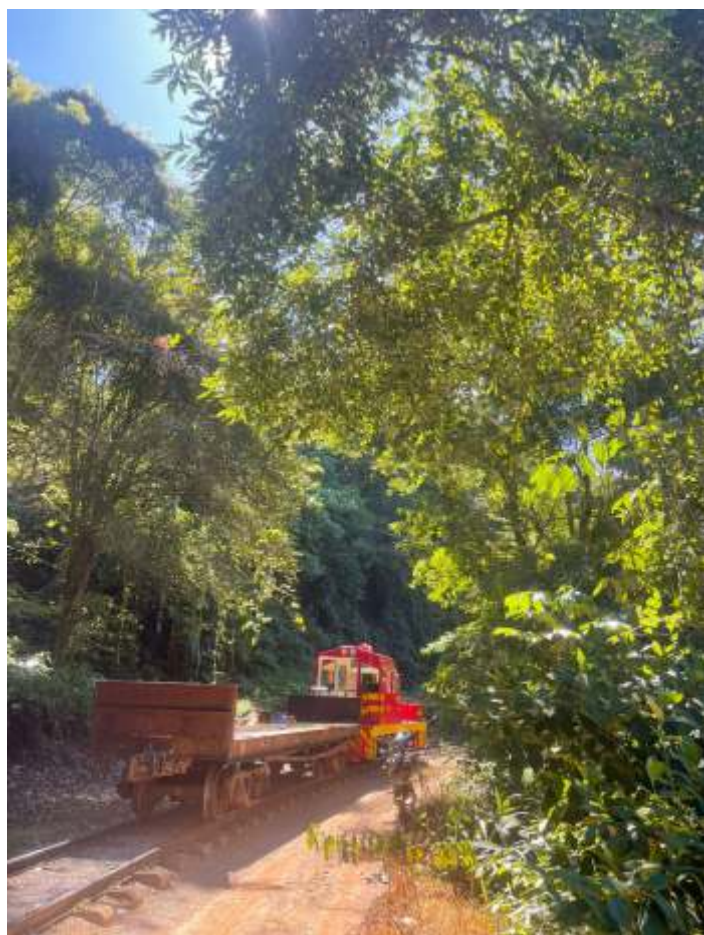
♦ Serviço de poda de galhos ao longo da via.
