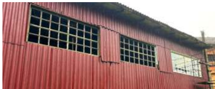
♦ Janelas que irão receber recuperação pelas Equipes de manutenção, novos vidros e pintura da estrutura de madeira.
