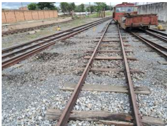
♦ Serviço de substituição de dormentes nas linhas do pátio das oficinas de Cruzeiro.
