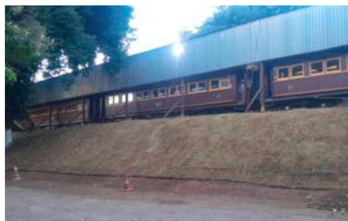
♦ Gramado novo no talude do lado oposto à frente da estação. Foto HGF.
