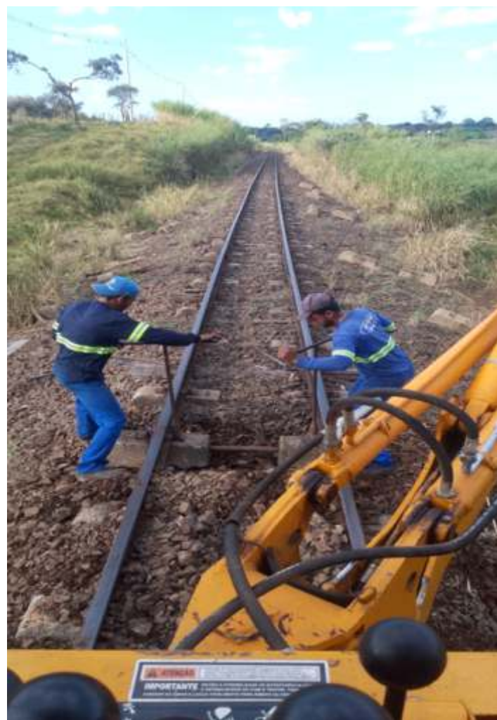
♦ Colaboradores reapertando parafusos após a troca. Foto Márcio Silva.
