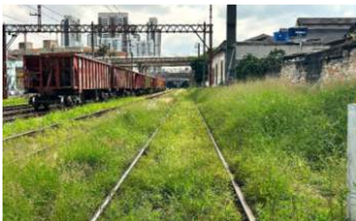
♦ Aspecto da via antes da roçada sentido Estação Brás.
