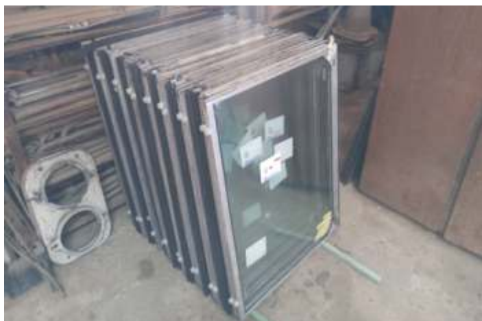
♦ Janelas prontas, revisadas e com novos vidros. Foto HGF
