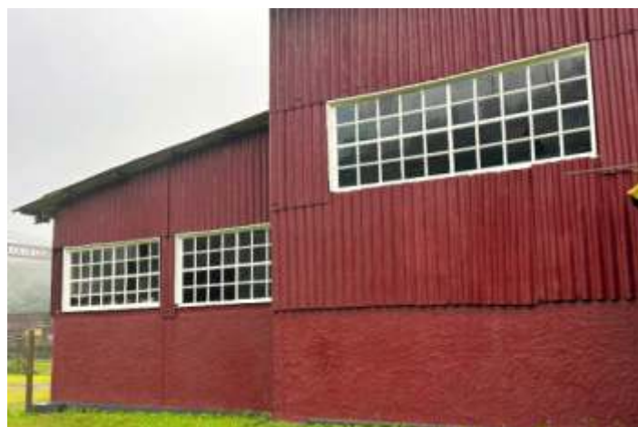
♦ As estruturas pós manutenção com a pintura branca tradicional destas janelas.
