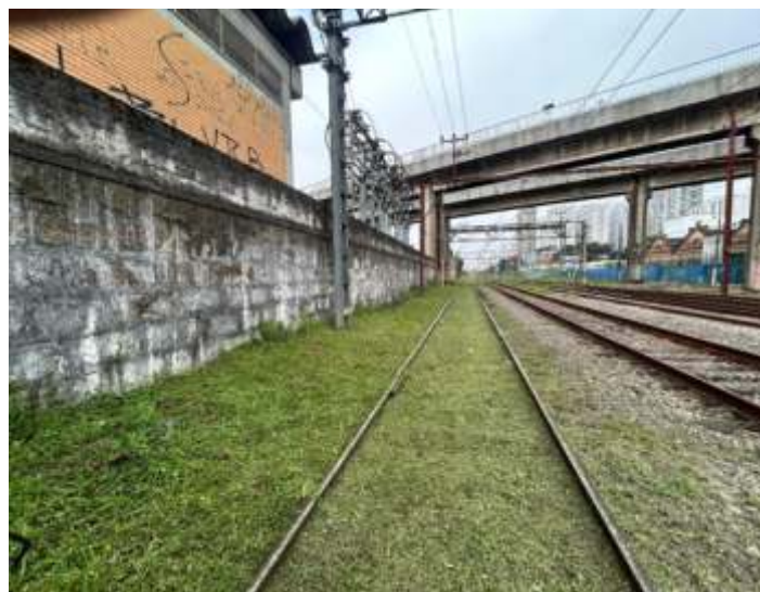
♦ Lado Mooca sendo observado do Brás, tendo os dois Viadutos da L-3 do Metrô de SP.
