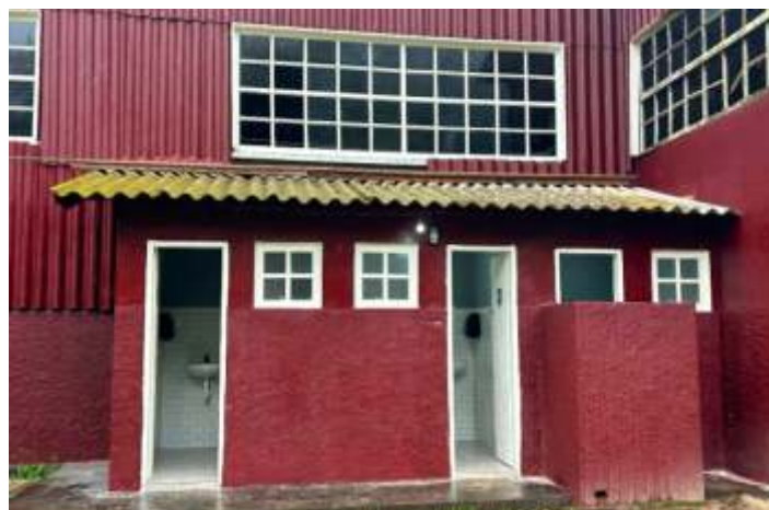
♦ Visão externa de ambos os banheiros pós manutenção.
