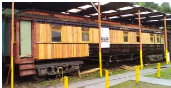
♦ Com o madeiramento já aplicado na parte central e início da parte inferior.
