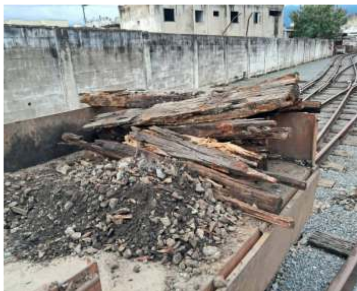
♦ Após a substituição, os dormentes removidos são recolhidos pela equipe de manutenção da via.
