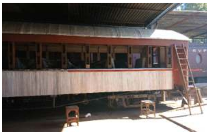
♦ Etapa de pintura com tinta niveladora de fundo.
