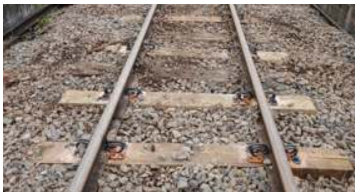
♦ Serviço de troca de alguns dos seis mil dormentes necessários para recuperação da via.
