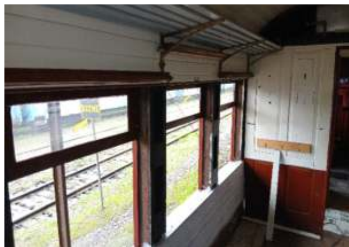
♦ Etapa de reconstrução do madeiramento interior do carro de passageiros PM-34.
