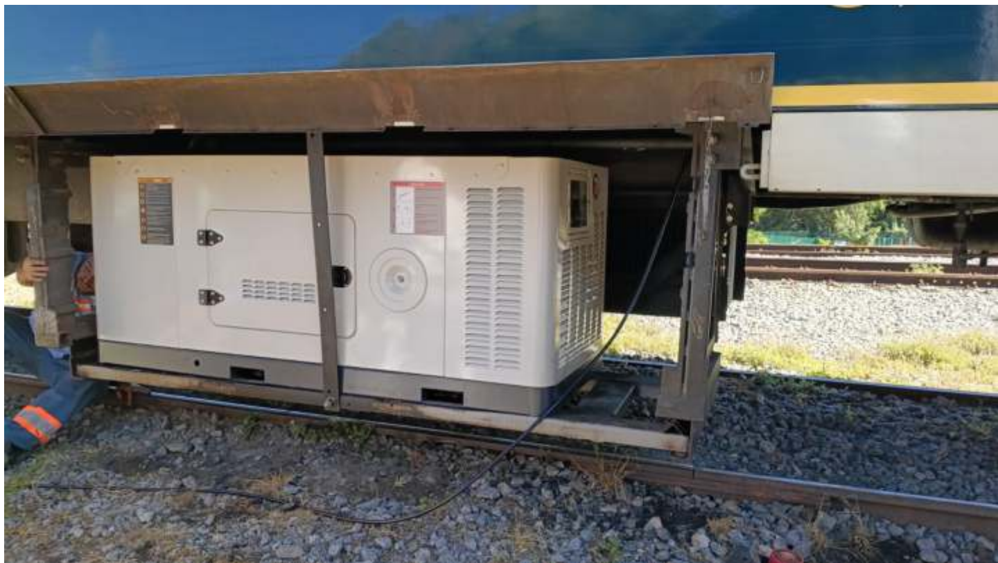
♦ O novo gerador já instalado sob o assoalho do carro restaurante.
