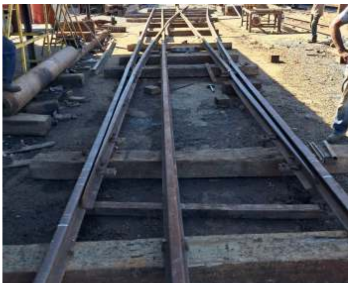
♦ Processo de construção do AMV.
