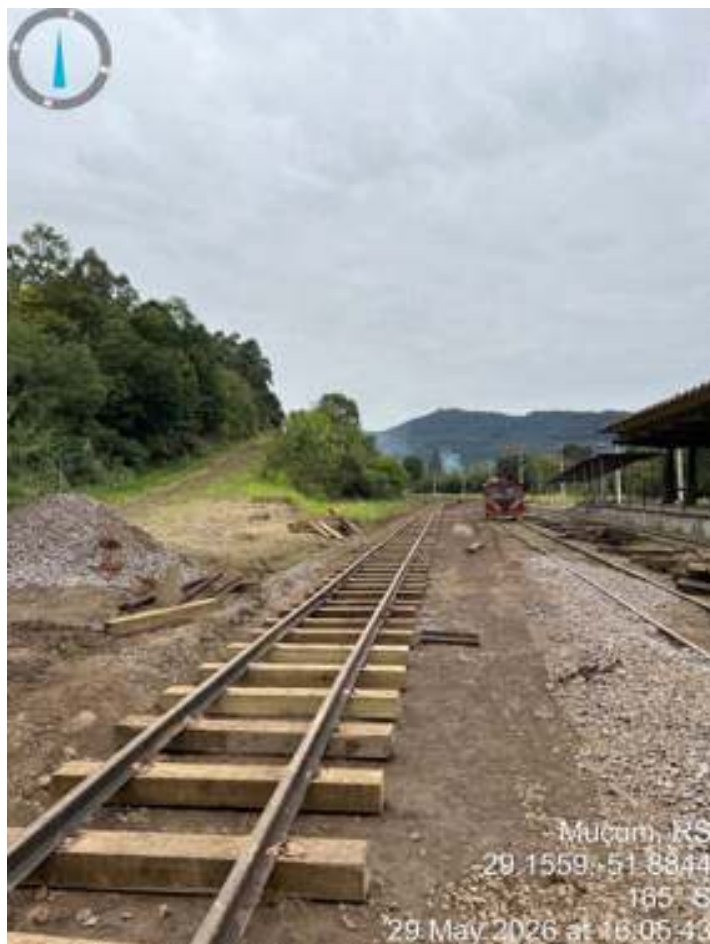
♦ Vista da terceira linha de desvio, implementada para descarregamento de material.
