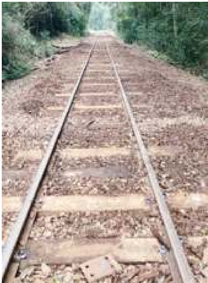
♦ Serviço de substituição dormentes km 845+000.
