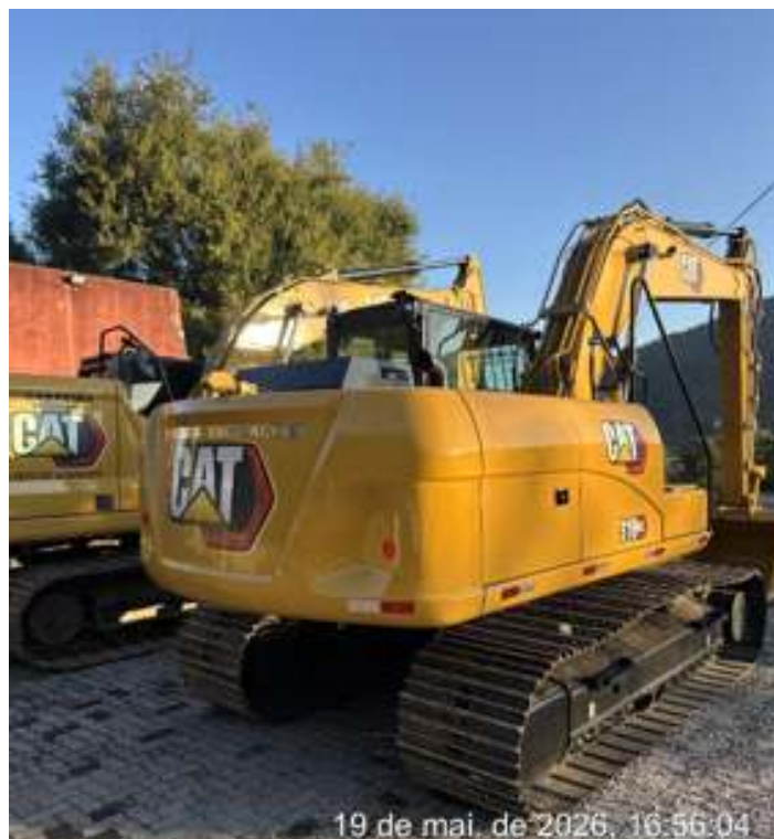
♦ As escavadeiras para remoção do material recém-chegadas à Muçum/RS.
