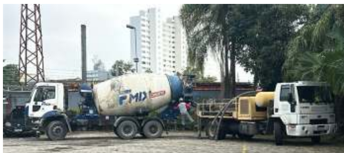
♦ Trabalho das equipes responsáveis pela concretagem da viga baldrame.
