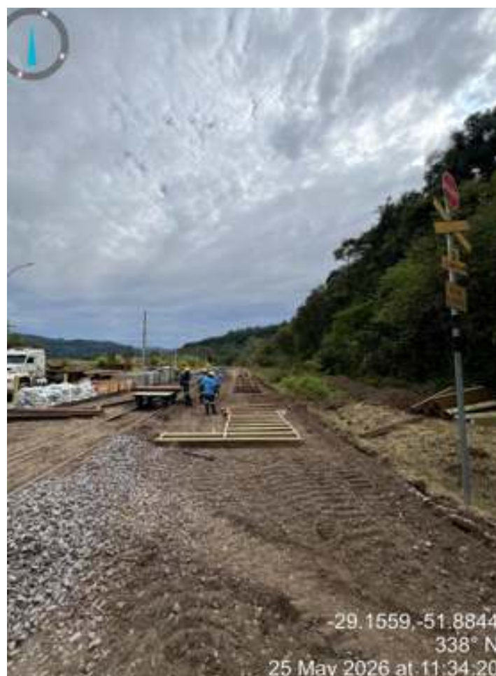
♦ Etapa de implementação de aparelho de mudança de via, ligando a desviada à terceira linha.
