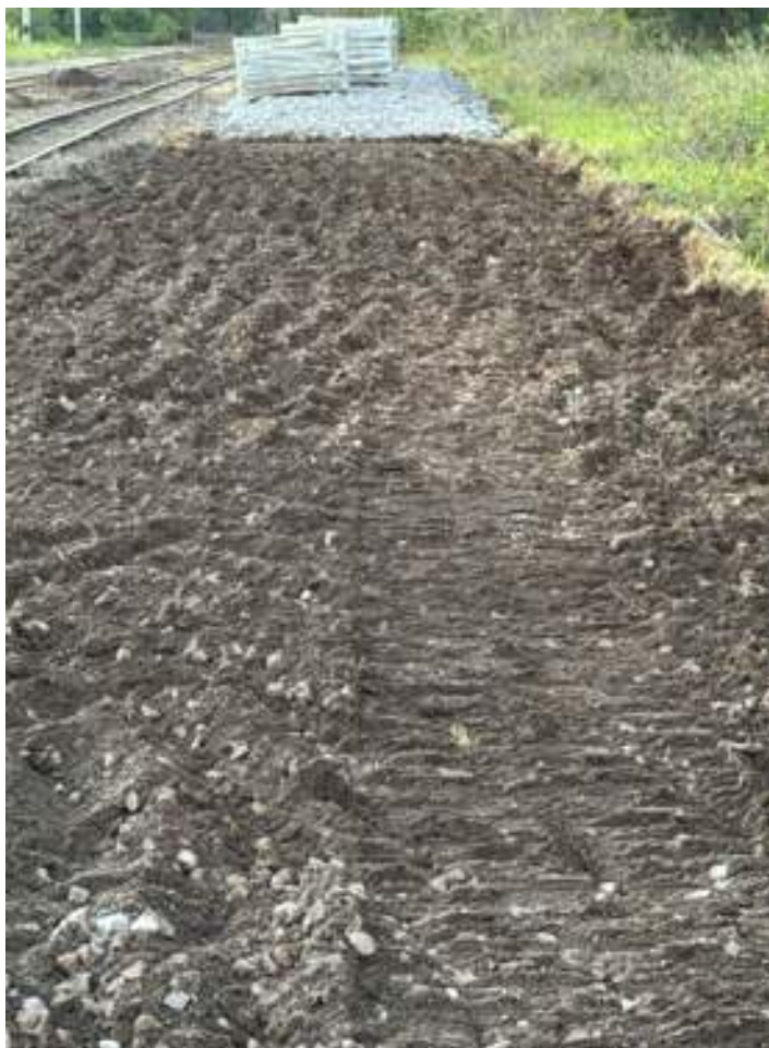
♦ Etapa de preparo do leito ferroviário para receber a rampa.
