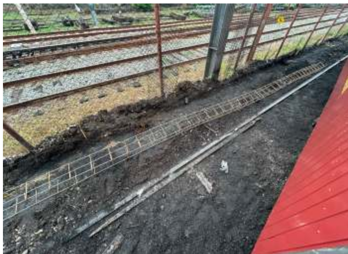
♦ Preparação do solo para posicionar a armadura da viga baldrame.
