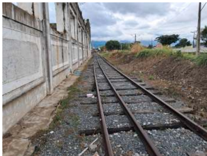
♦ Serviço de manutenção das vias do pátio, com substituição de dormentes.
