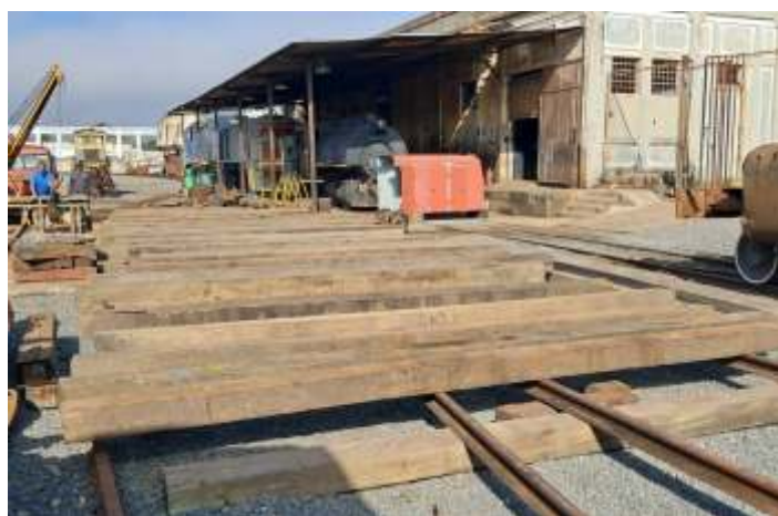
♦ Serviço de manutenção das vias do pátio, com limpeza e substituição de dormentes.
