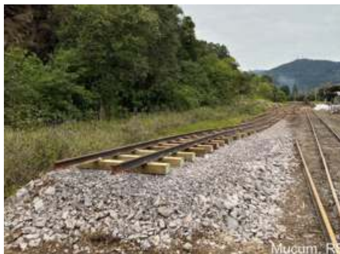
♦ Vista da rampa em fase de finalização.
