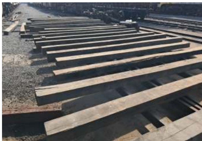
♦ Construção de AMV de bitola larga com passagem para bitola mista.
