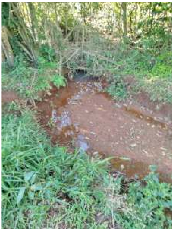
♦ Serviço de limpeza dos bueiros para drenagem no km852+340.
