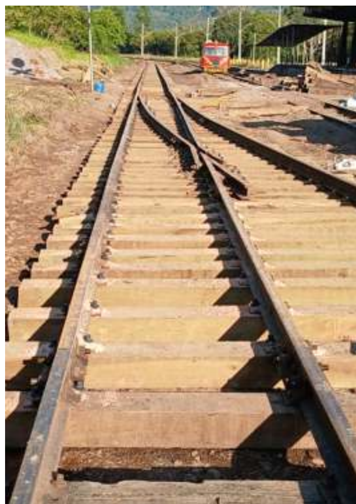
♦ Aparelho de mudança de via já devidamente implantado.
