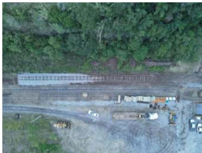
♦ Vista aérea da construção da rampa.
