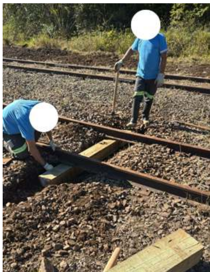
♦ Primeiro dormente sendo trocado pelo projeto de recuperação da ferrovia.
