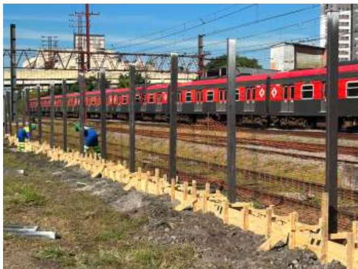
♦ Atividade de instalação em andamento.
