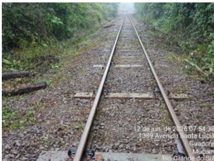
♦ Serviço de troca de alguns dos seis mil dormentes necessários para recuperação da via.
