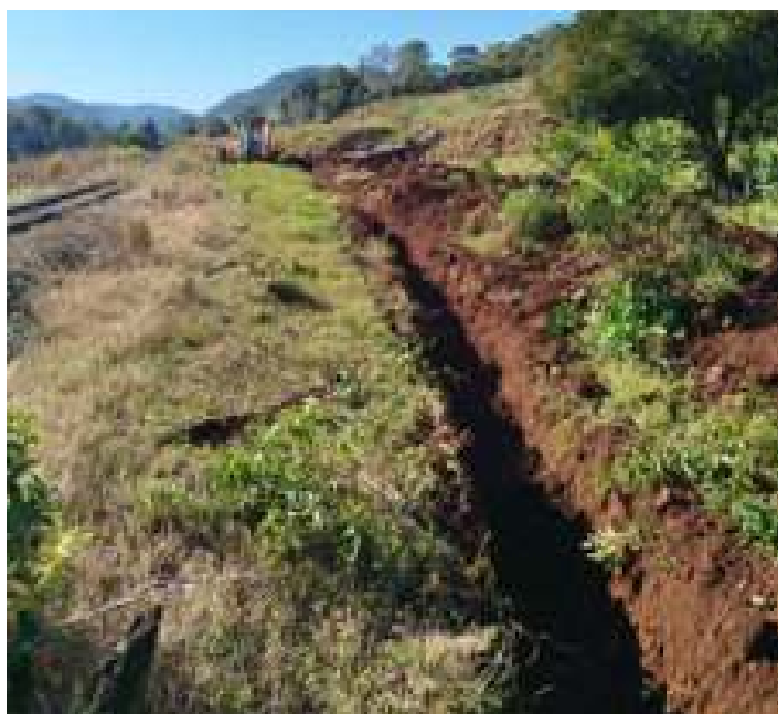
♦ Serviço de limpeza abertura de valeta para drenagem no km 853+700.
