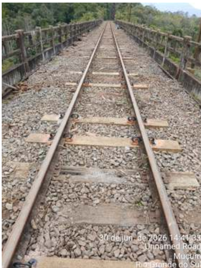
♦ Serviço de troca de dormentes no viaduto 05.
