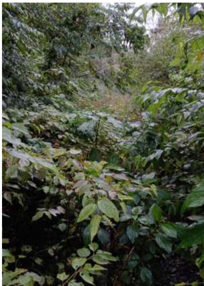
♦ Aspecto do leito ferroviário após dois anos de desativação.
