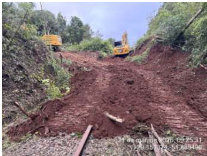
♦ Início dos trabalhos de remoção do material, primeira barreira.
