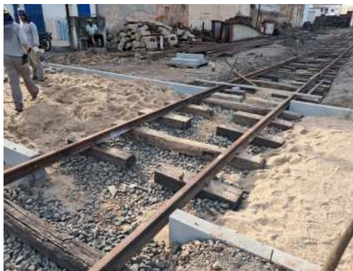
♦ Ampliação da linha de bitola larga no pátio da ABPF.
