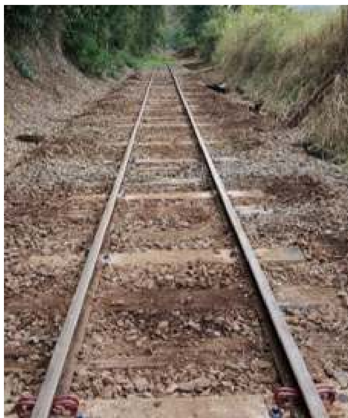
♦ Substituição dormentes km 844+700 ao 845+900.
