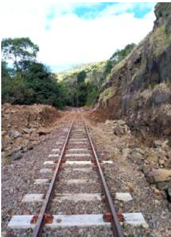
♦ Limpeza barreira km 855+730.
