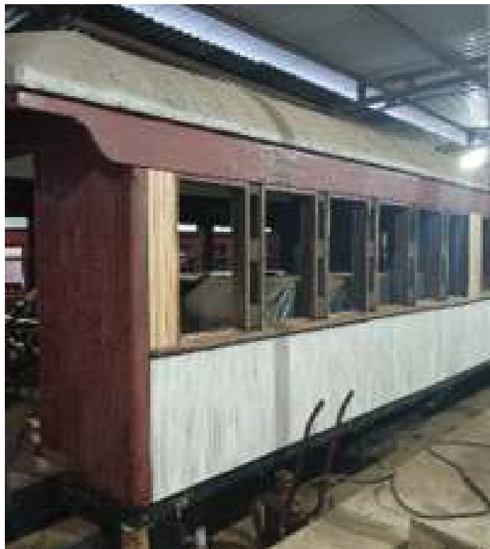
♦ Etapa de pintura de fundo do madeiramento do carro de passageiros PD-47.
