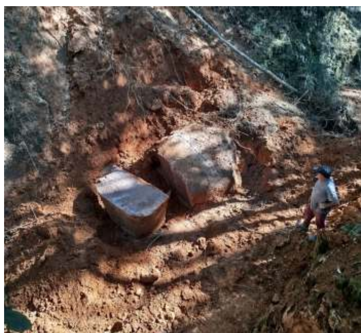
♦ Uma das rochas que precisou ser detonada, sendo depositada ao lado da via férrea, com compreensão e consentimento do dono do terreno limítrofe à via. Autor: Otávio Georg Junior.
