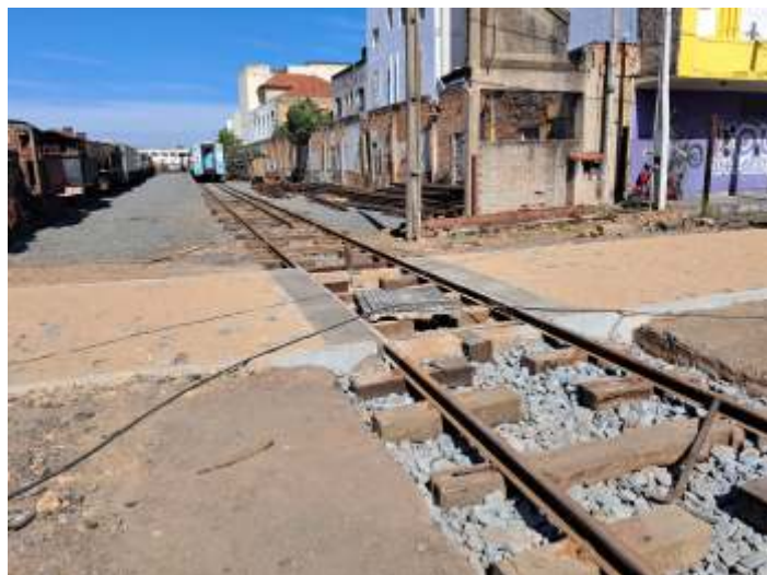
♦ O Novo acesso para a estação em fase de construção.
