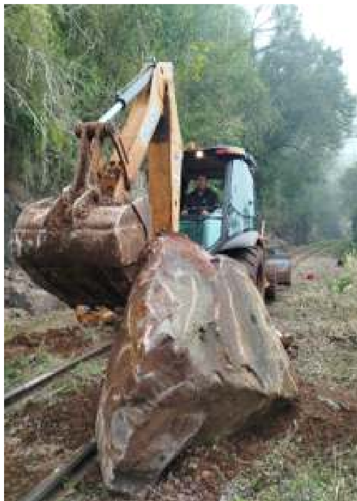
♦ Limpeza barreira km 854+650.
