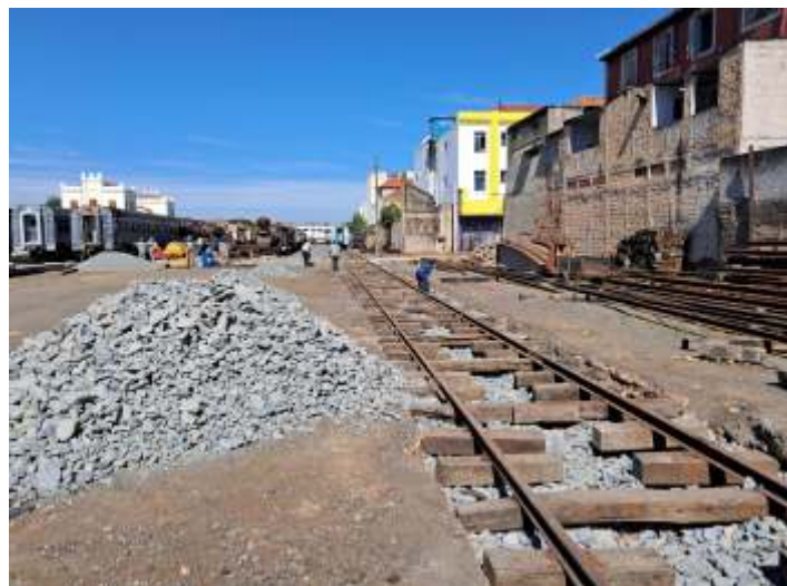
♦ Ampliação da linha de bitola larga no pátio da ABPF.
