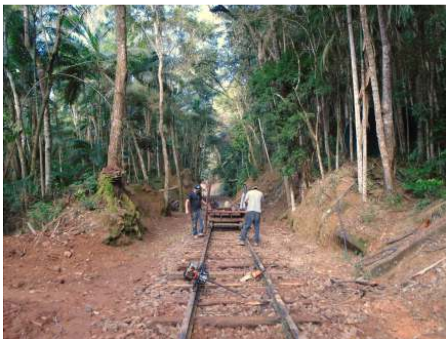
♦ Imagem do local da barreira, já retirada e manutenção da via sendo feita pelo mestre de linha jefferson Dhein. Autor: Luiz Carlos Henkels
