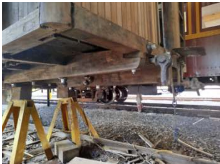
♦ Aspecto do carro após a substituição das travessas.
