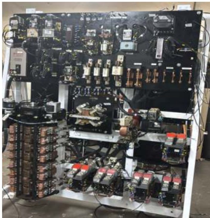
♦ Detalhe do armário elétrico da G12 em montagem.
