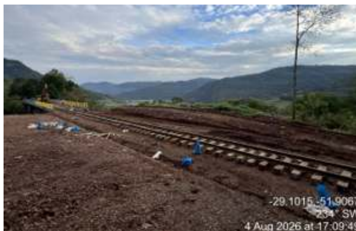
♦ Distribuição de dormentes e início de montagem da grade.
