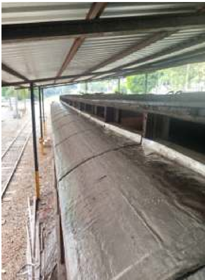
♦ Aspecto de antes e depois da instalação da manta asfáltica no teto.
