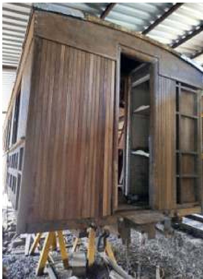
♦ Etapa de substituição de parte do madeiramento externo do carro.
