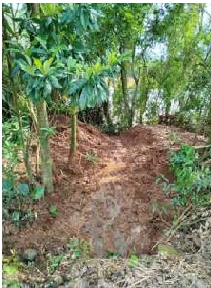
♦ Limpeza de bueiros, galerias e canaletas para escoamento de águas pluviais.
