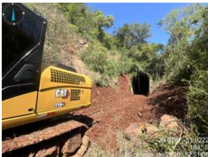
♦ Remoção de barreira em boca de túnel. Este é o último túnel com obstruções.
