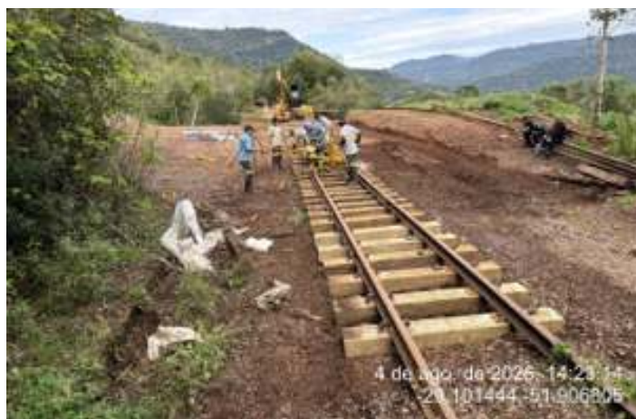
♦ Etapa de montagem da grade.
