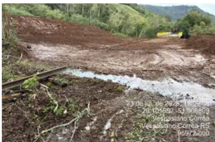
♦ Aspecto do mesmo local preparado para o início das atividades de reconstrução da grade.
