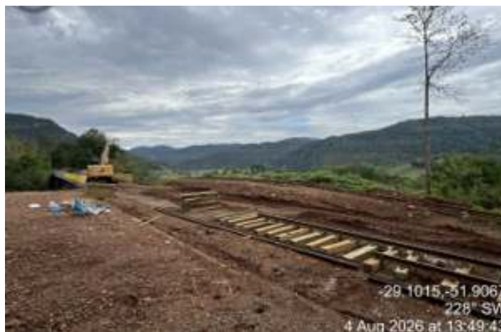
♦ Distribuição de dormentes e início de montagem da grade.
