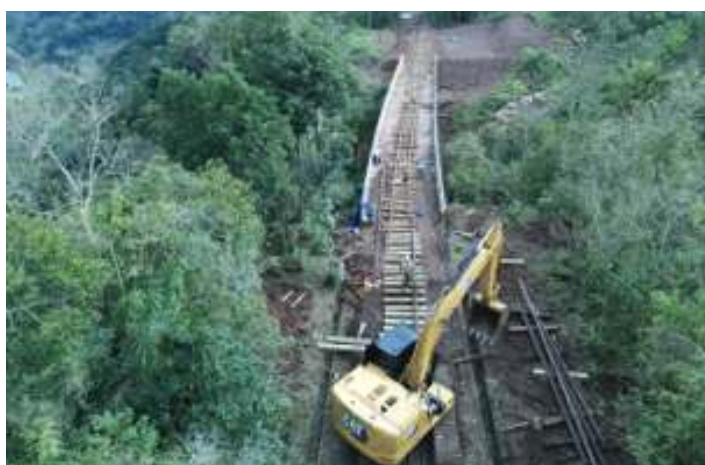
♦ Imagem de drone da finalização de montagem da grade.
