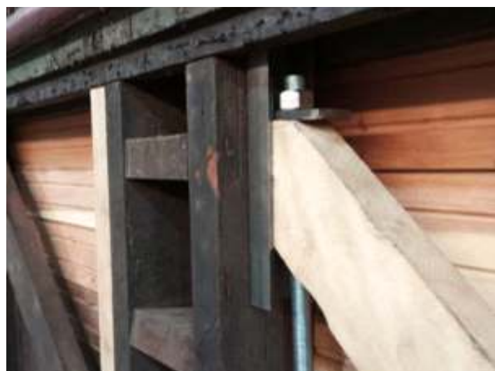
♦ Etapa de reforço do madeiramento estrutural do carro de passageiros PD-47.
